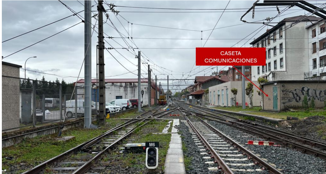
Figura 1. Caseta de comunicaciones
