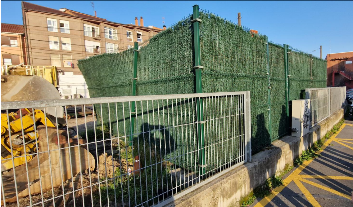
Figura 14. Instalación de URA en parcela
