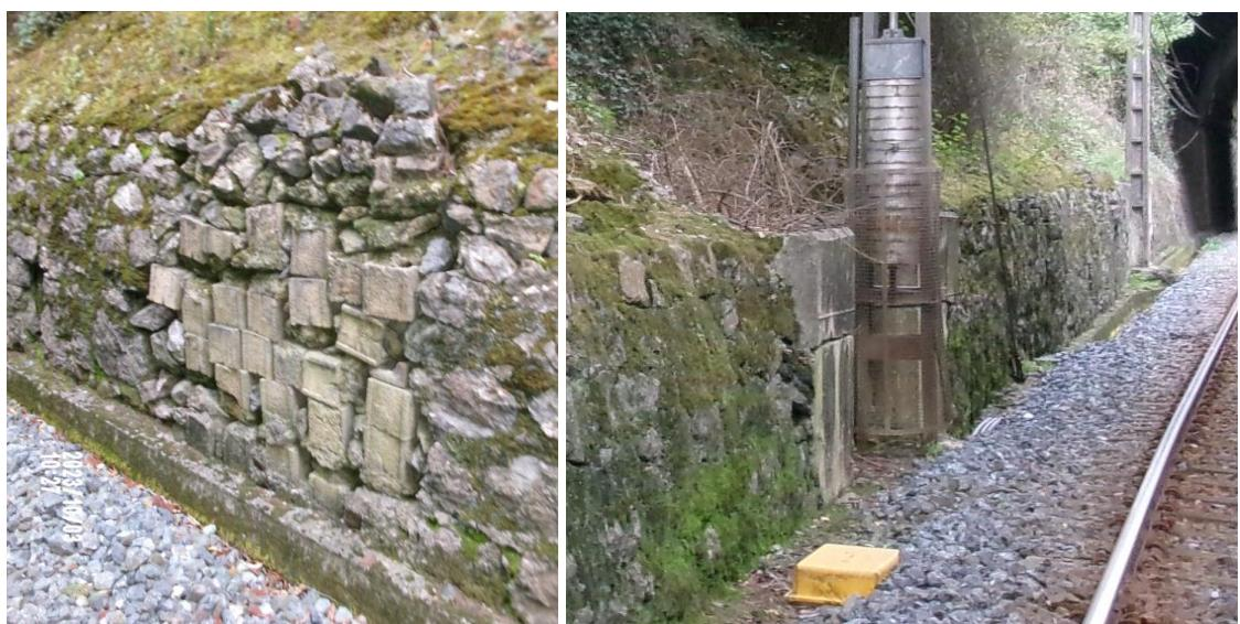
Se observa el muro de mapapostería incial ha sido sustituido en esta zona por bloques de hormigón prefabricado que se mantienen estables. Esto indica que, el terreno no está realizando ningun empuje sobre el trasdós ya que, si no estos bloques hubieran deslizado.
