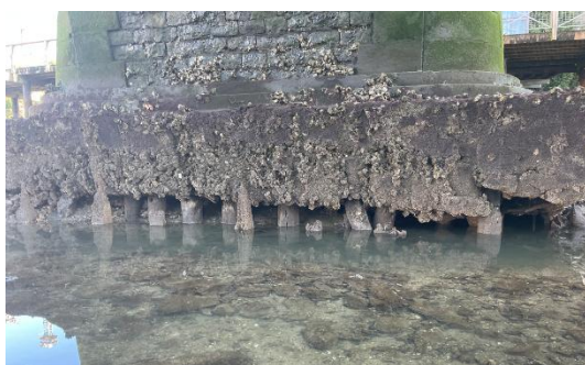
5. irudia. 4. pila Piloteak agerian
