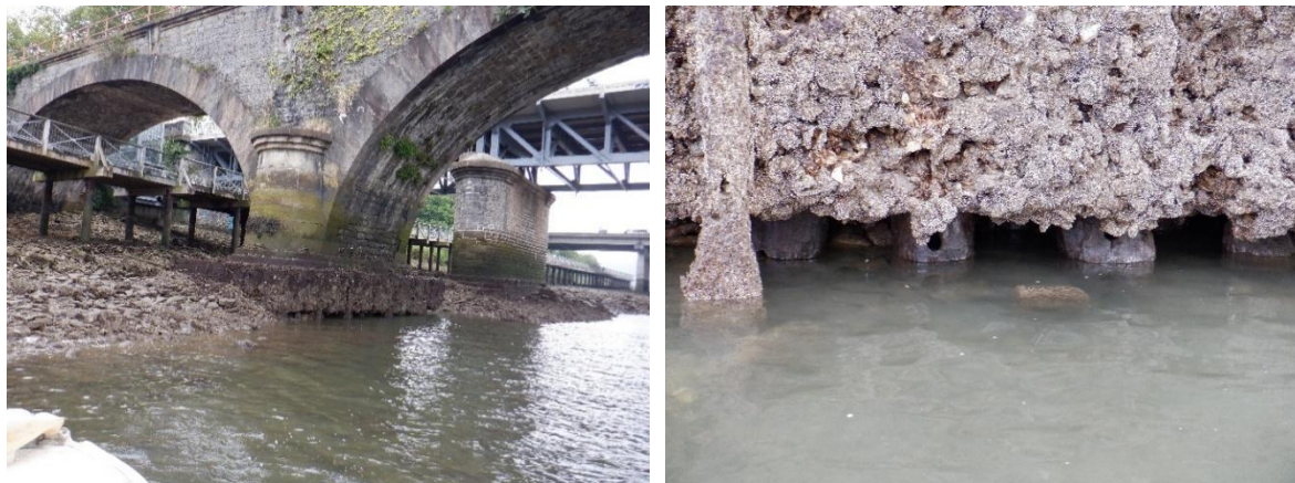
19. irudia. 4. pila egurrezko piloteekin airean
