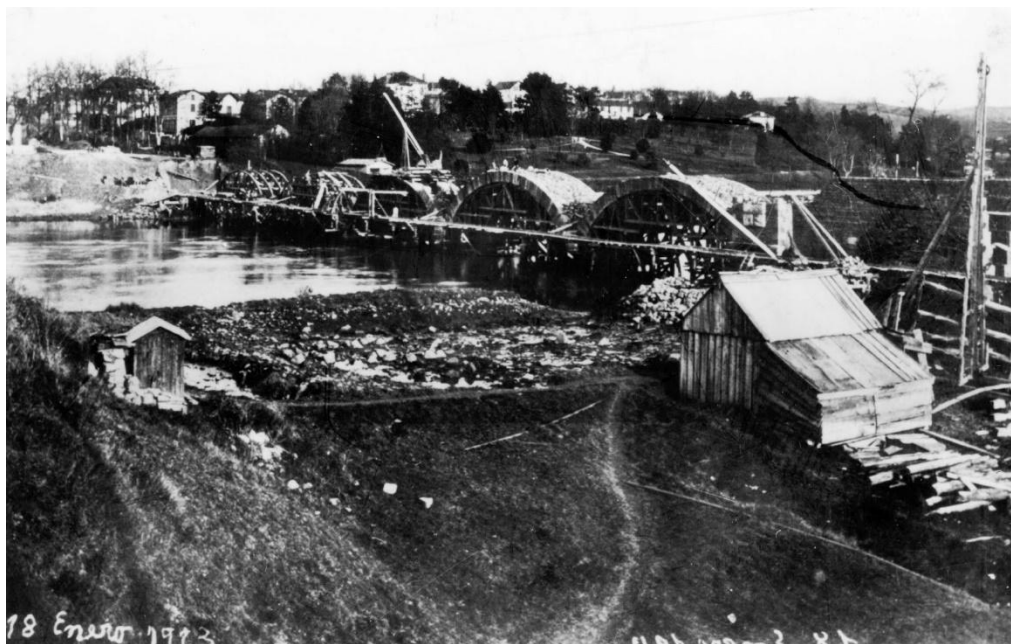
1. irudia. ETSren Irungo nazioarteko zubiaren gangak egiteko zinbriak, Irundik begiratuta (1913ko urtarrilak 18)
