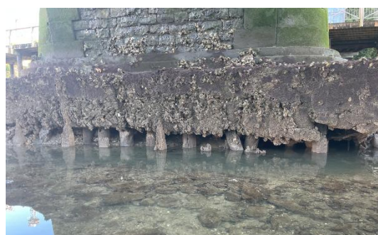
30. irudia 4. pila Agerian dauden piloteak
