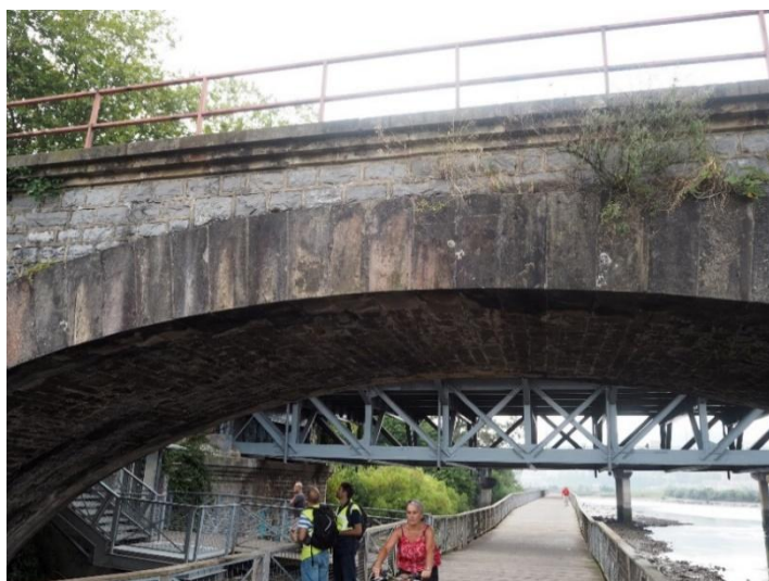
Figura 12. Vista aguas arriba desde pasarela
