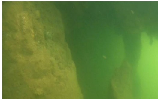
Figura 6. Pila 1. Cavity bajo encepado
