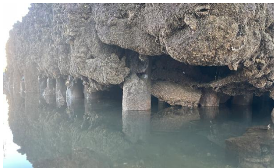
Figura 29. Pila 4. Socavación
