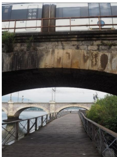
Figura 11. Vista aguas abajo desde pasarela
