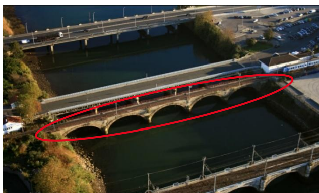
Figura 8. Ubicación en perspectiva aérea desde aguas abajo
