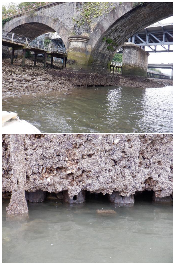
Figura 19. Pila 4 con pilotes de madera al aire
