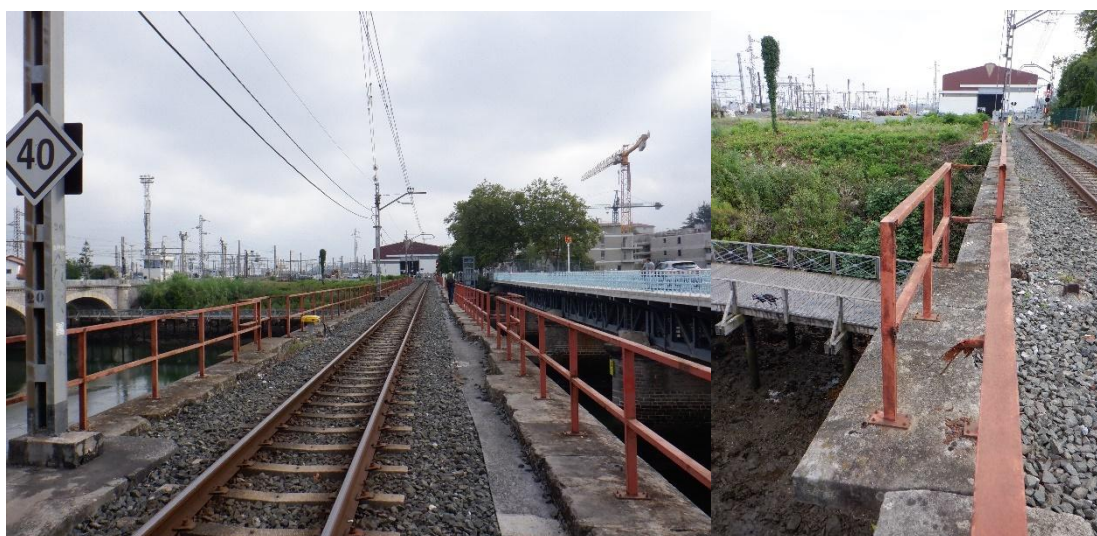
Figura 23. Vista superestructura y apartaderos en pila
