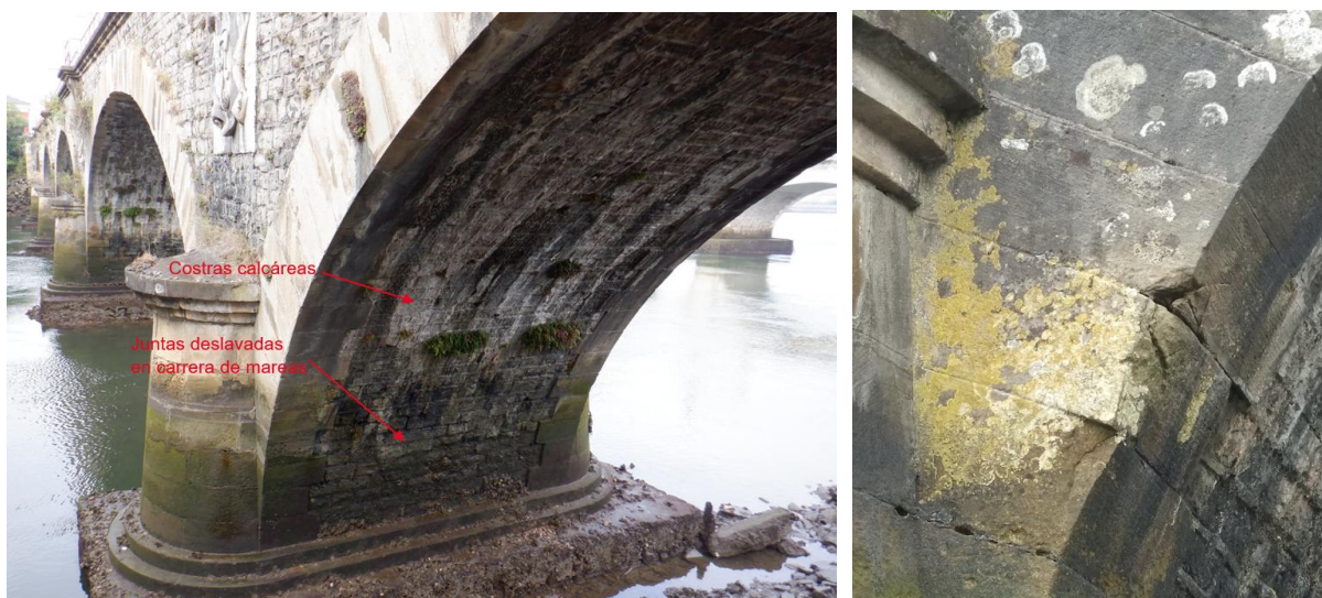
Figura 33. Afecciones bóvedas
