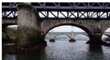
Figura 13. Vista aguas arriba desde embarcación
