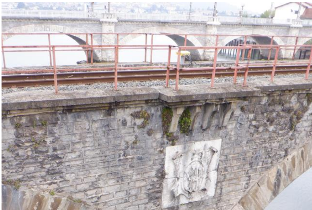
Figura 22. Viguetas descansillos en pilas
