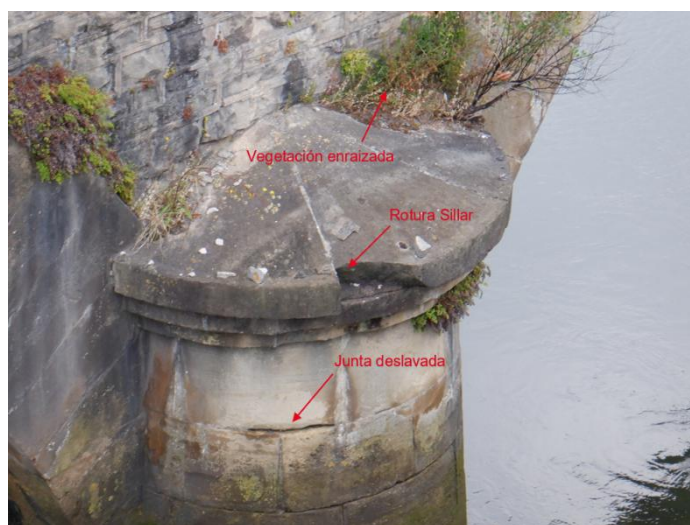
Figura 32. Afecciones pilares
