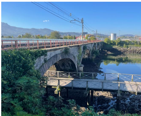
Figura 25. Vegetación enraizada en vista general
