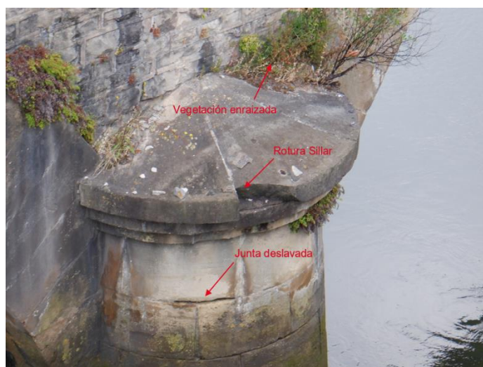
Figura 32. Afecciones pilares
