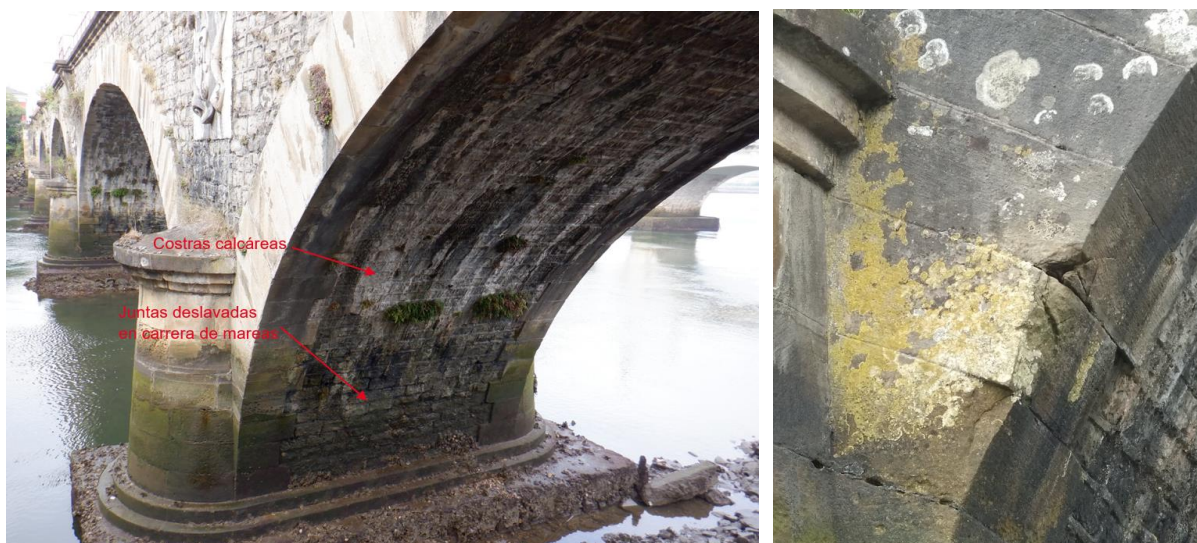
Figura 33. Afecciones bóvedas
