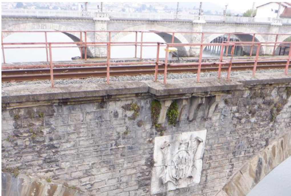
Figura 22. Viguetas descansillos en pilas
