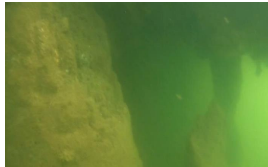
Figura 6. Pila 1. Cavidad bajo encepado
