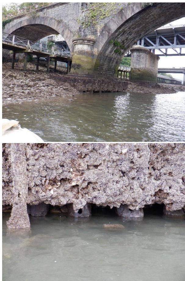
Figura 19. Pila 4 con pilotes de madera al aire
