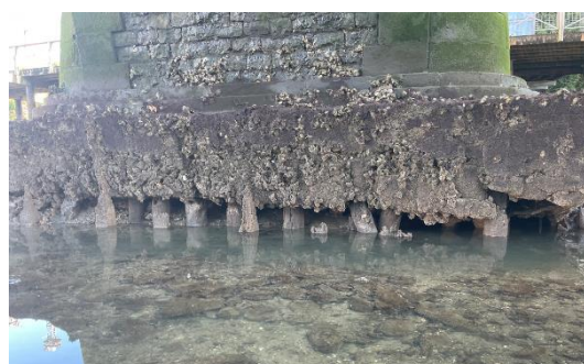
Figura 30. Pila 4. Pilotes descubiertos
