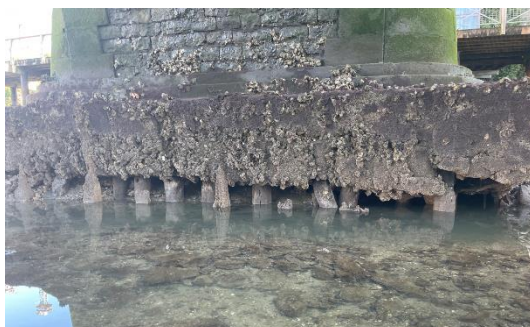
Figura 5. Pila 4. Pilotes descubiertos
