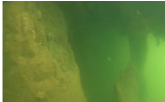
Figura 6. Pila 1. Cavidad bajo encepado
