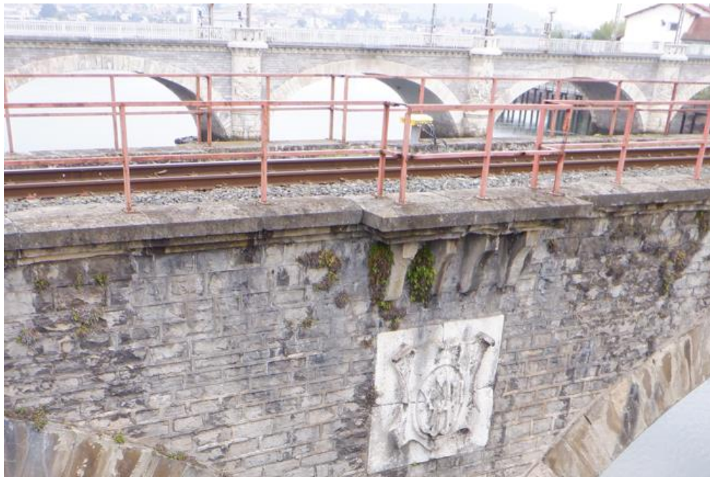
Figura 11. Viguetas descansillos en pilas
