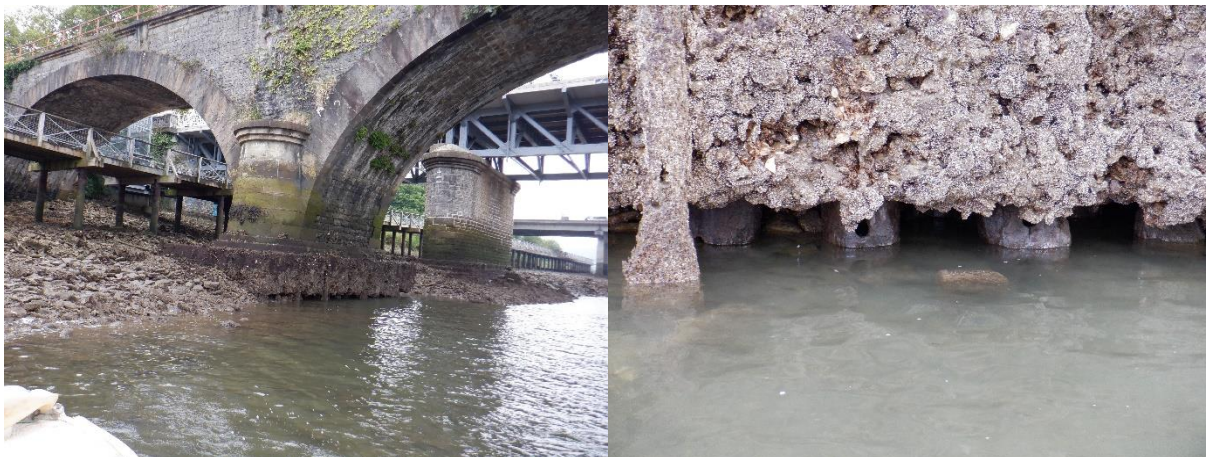
Figura 9. Pila 4 con pilotes de madera al aire
