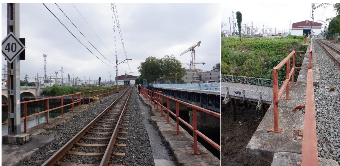
Figura 12. Vista superestructura y apartaderos en pila
