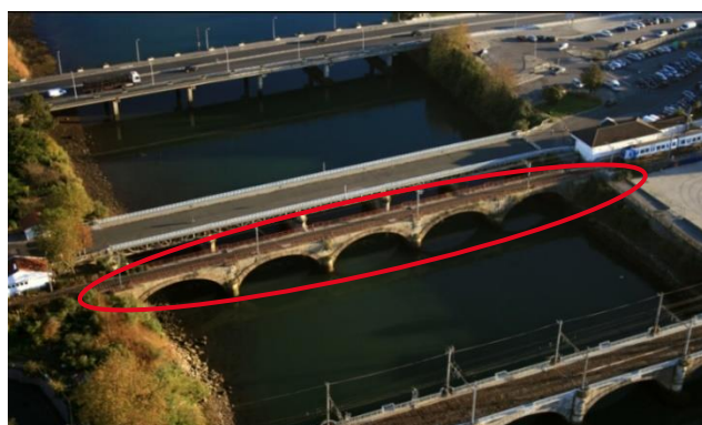
Figura 6. Ubicación en perspectiva aérea desde aguas abajo
