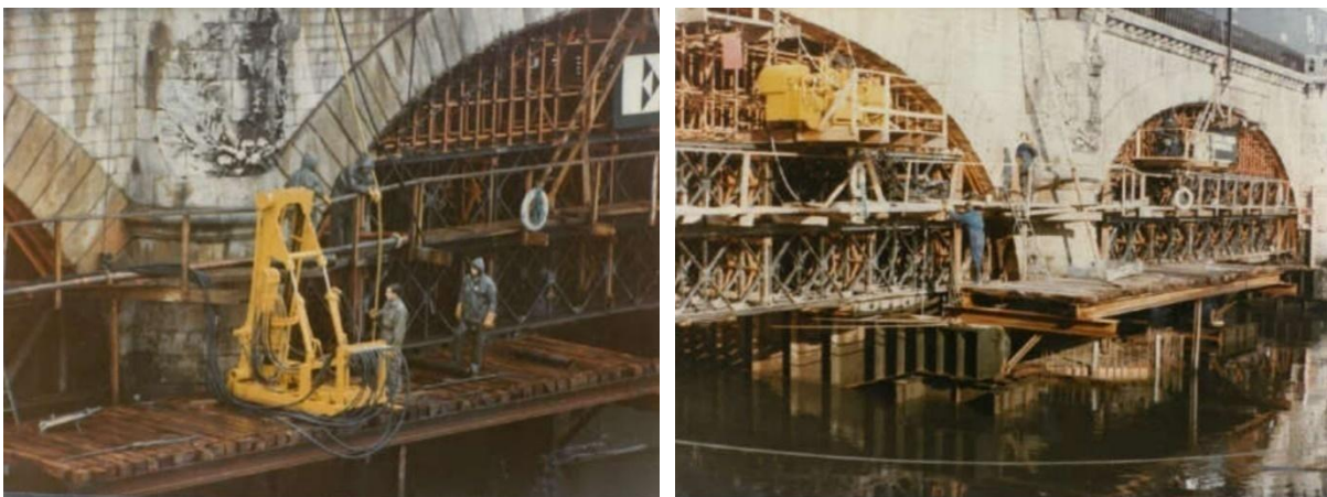
Figura 50. Refuerzo mediante micropilotes realizado en el puente de ADIF
