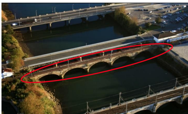
Figura 4. Ubicación en perspectiva aérea desde aguas abajo
