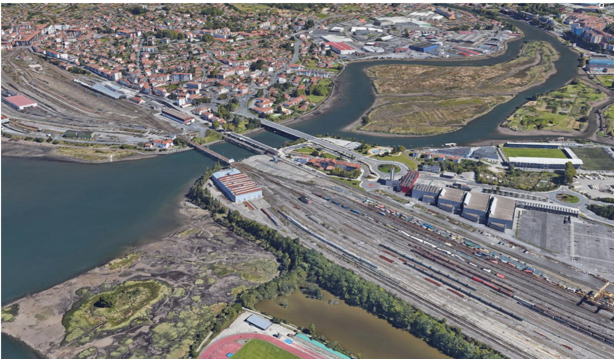
Figura 49. Vista aérea del puente entre otros tres puentes entre zonas de instalaciones ferroviarias
