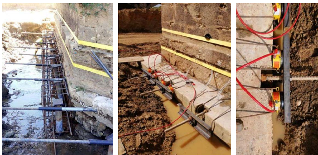
Figura 41. Recalce micropilotes de forma perimetral y tesado de pasadores para transmisión de esfuerzos
