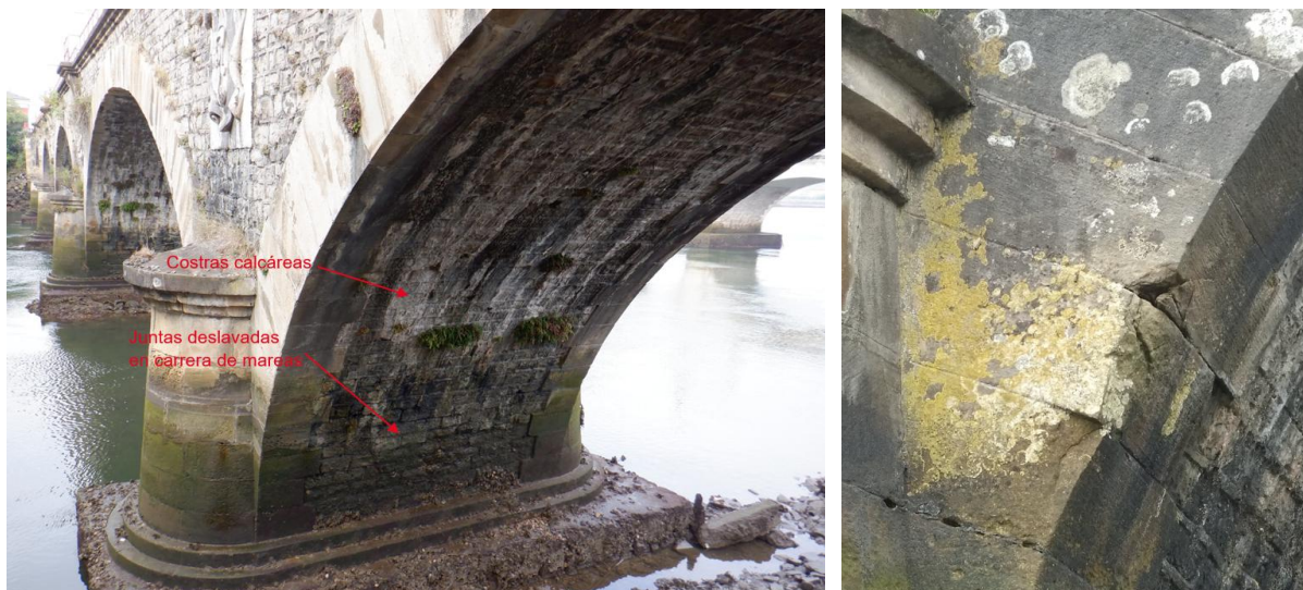
Figura 24. Afecciones bóvedas
