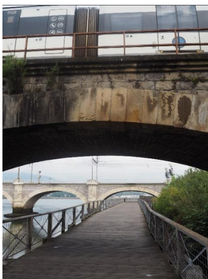
Figura 7. Vista aguas abajo desde pasarela
