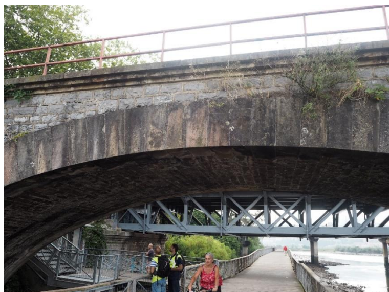
Figura 8. Vista aguas arriba desde pasarela
