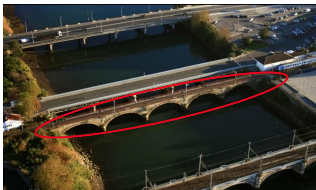
Figura 2. Ubicación en perspectiva aérea desde aguas abajo
