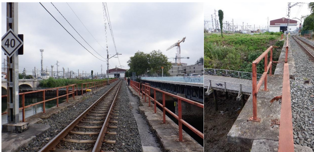
Figura 17. Vista superestructura y apartaderos en pila
