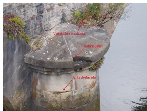
Figura 23. Afecciones pilares
