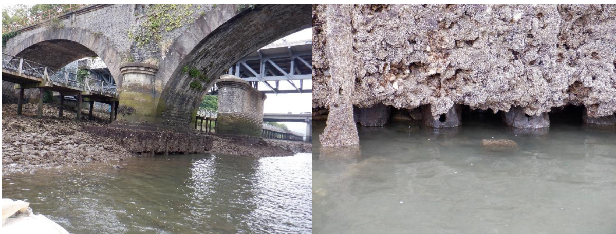
Figura 15. Pila 4 con pilotes de madera al aire
