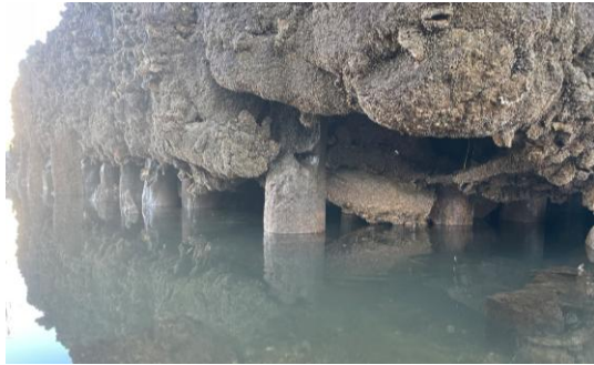
Figura 20. Pila 4. Socavación
