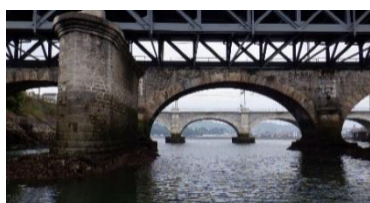
Figura 9. Vista aguas arriba desde embarcación
