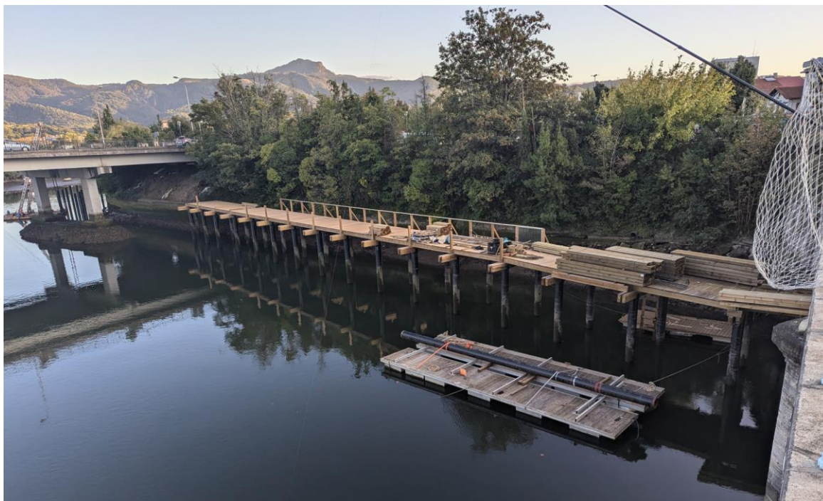
Figura 4. Montaje pasarela de madera
