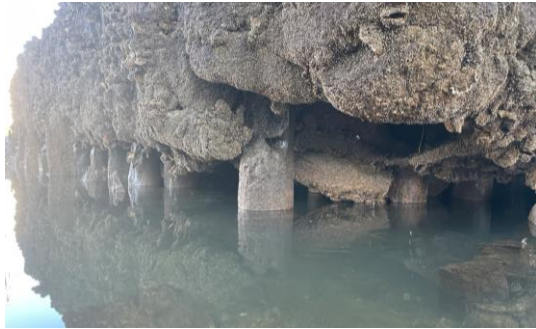
Figura 12. Pila 4. Socavación
