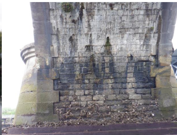
Figura 5. Vista transversal de bóveda
