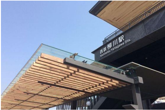
Ejemplos de lamas de madera bajo cubierta vidriada
