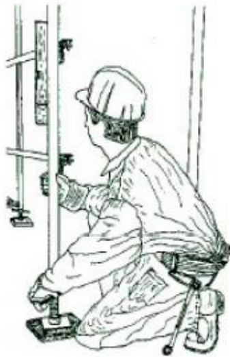
Comprobación de la nivelación vertical
