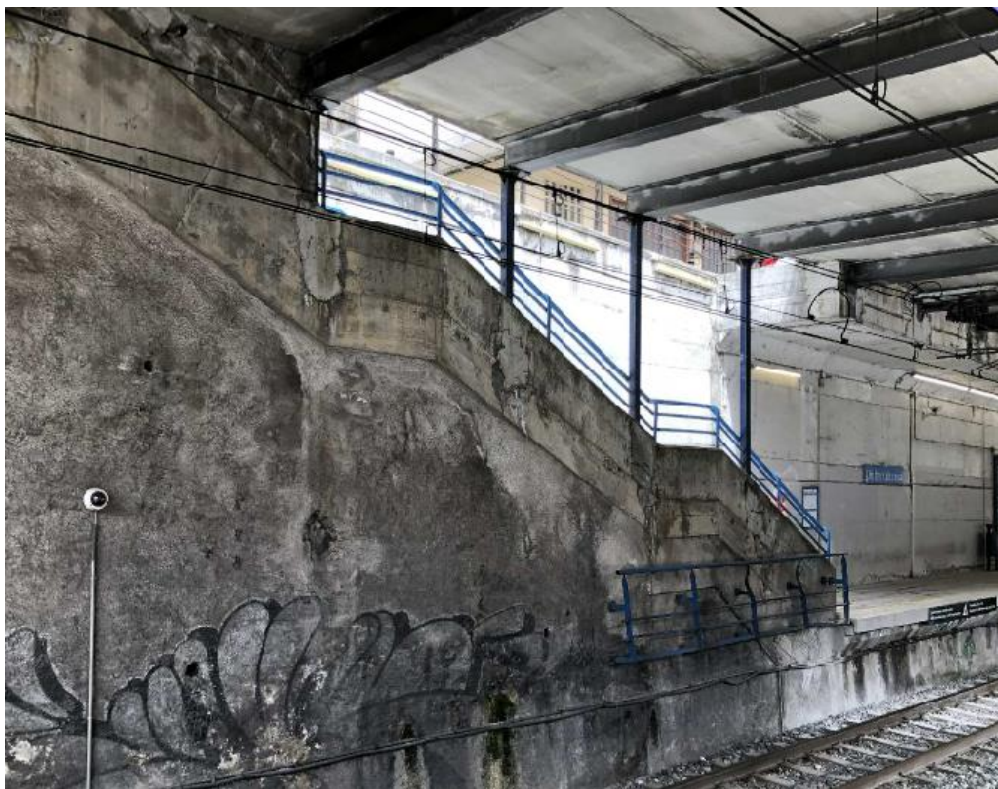
Fig.8: Imagen de los pilares a retirar para lo cual hay que apea el forjado existente
