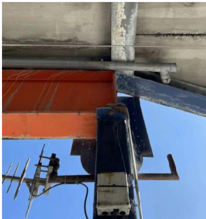
Fig.11: Imagen del pilar a retirar previo apeo de la viga HEA1000 principal
