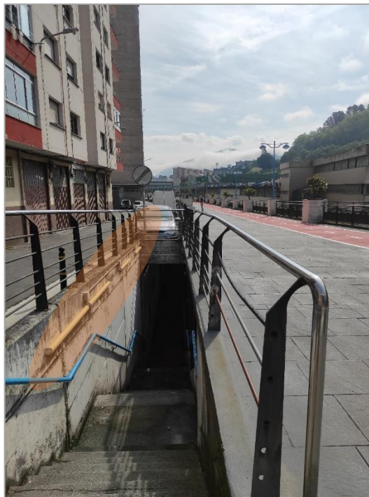
Luminarias existentes en el acceso al andén con sentido Donostia de la estación Unibertsitatea-Eibar.
