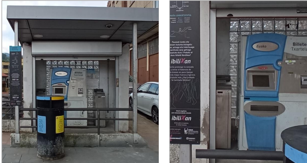
Canceladoras y maquina expendedora en la cubierta de estación Unibertsitatea-Eibar
