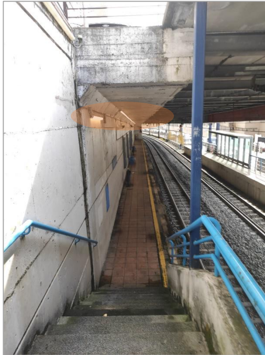
Acceso al andén con sentido Donostia de la estación Unibertsitatea-Eibar.
