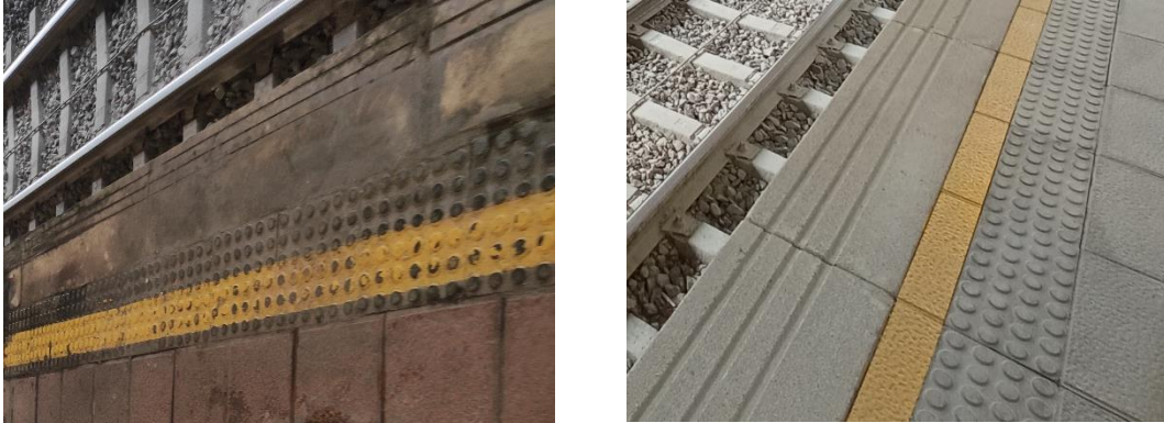
Modificación del embaldosado de acceso al tren.
