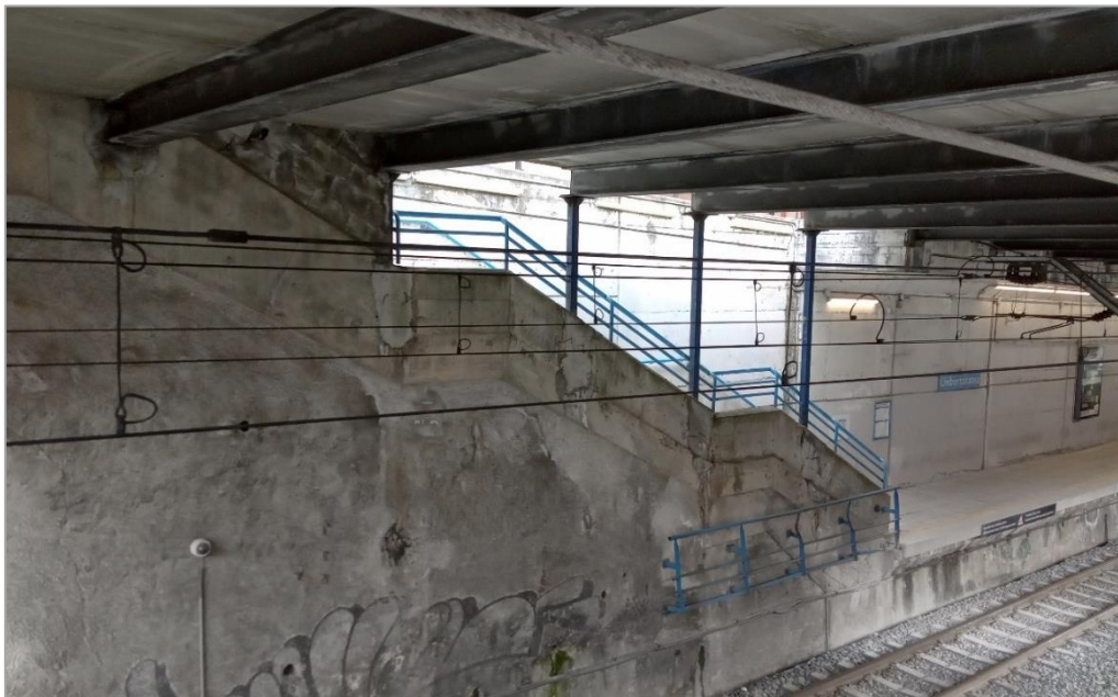
Escaleras de acceso a andén dirección Donostia.
