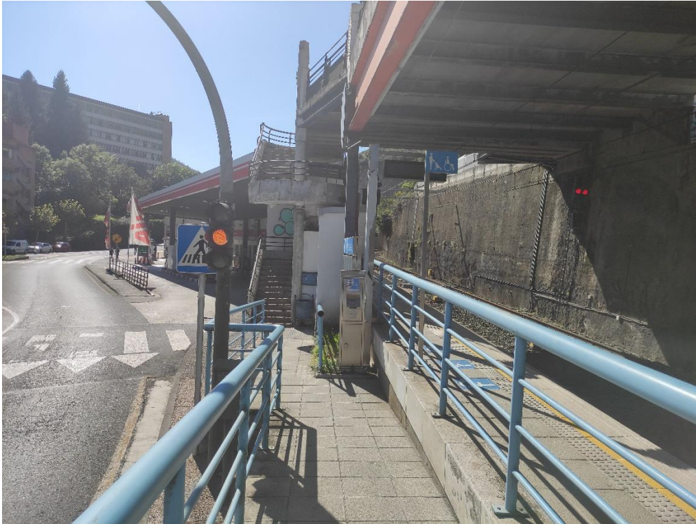
Rampa y escaleras de acceso a la zona superior de la estación, sin accesibilidad universal.
