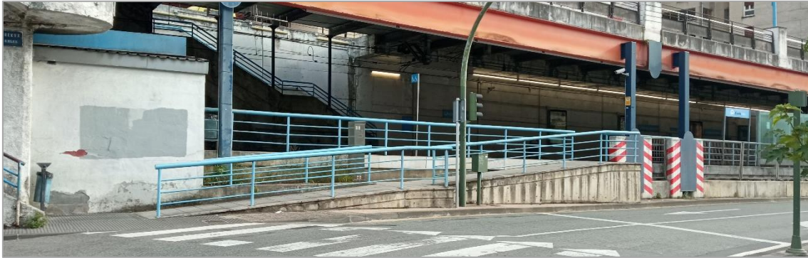
Acceso al andén en dirección Bilbao desde la calle Torrekua.
