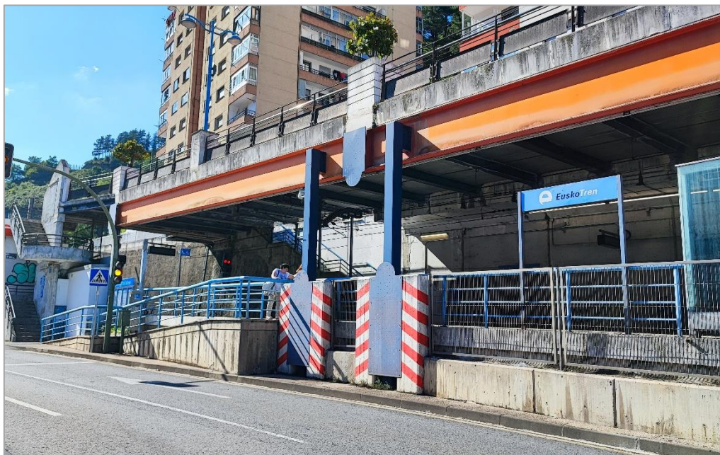
Estado actual acceso anden a través de rampa y sin ascensor a cota superior.
