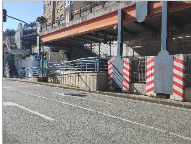
Entorno de la entrada al andén con sentido Bilbao
