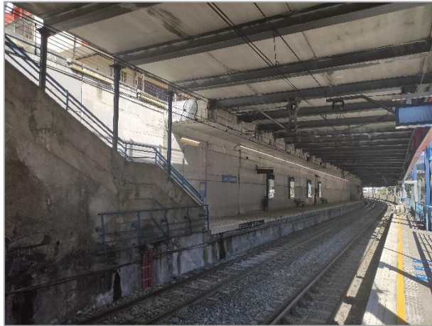
Escaleras de acceso al andén con sentido Donostia y andén sentido Bilbao
