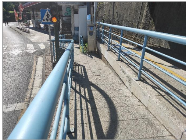
Acceso existente rampa acceso andén sentido Bilbao
