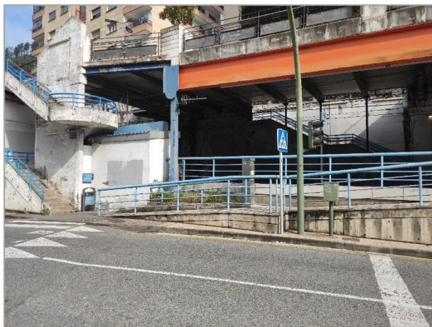
Acceso a andén con sentido Bilbao y escaleras de conexión con paso peatonal superior
