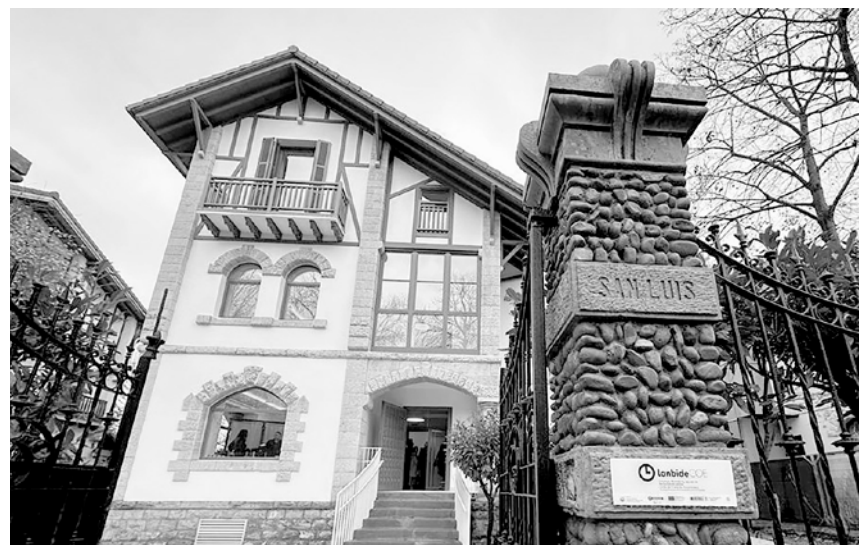
Edificio de la sede central del COE
