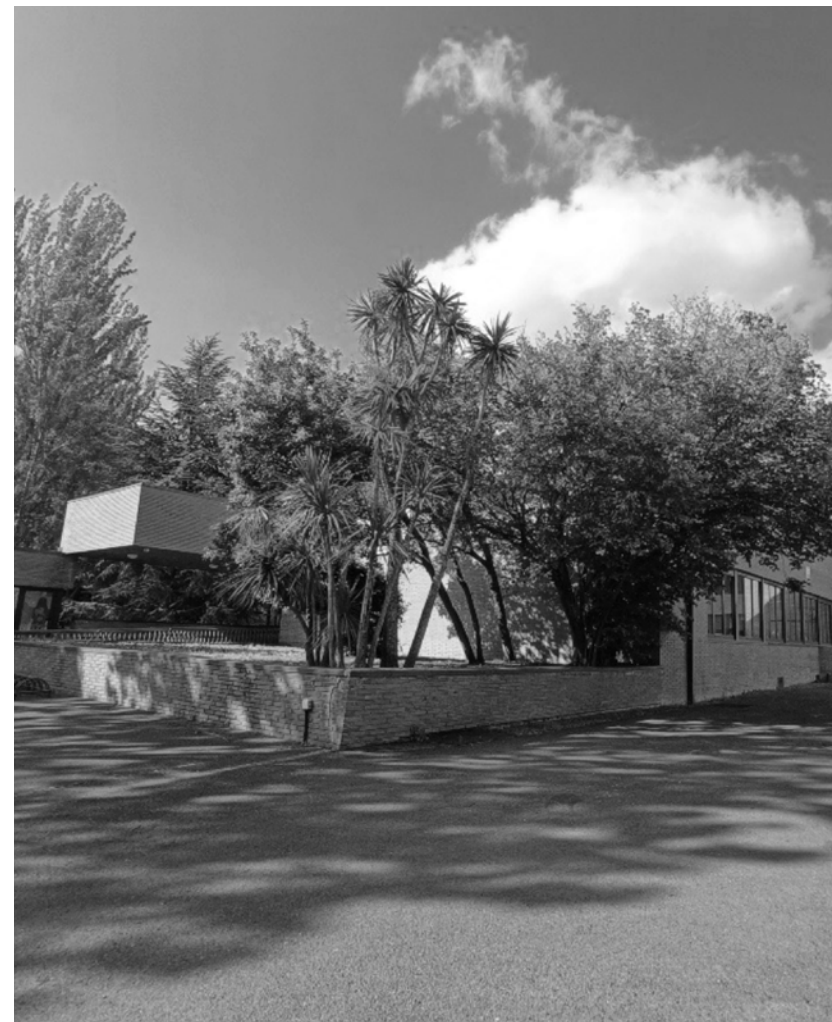
Edificio Servicios Centrales de Lanbide
