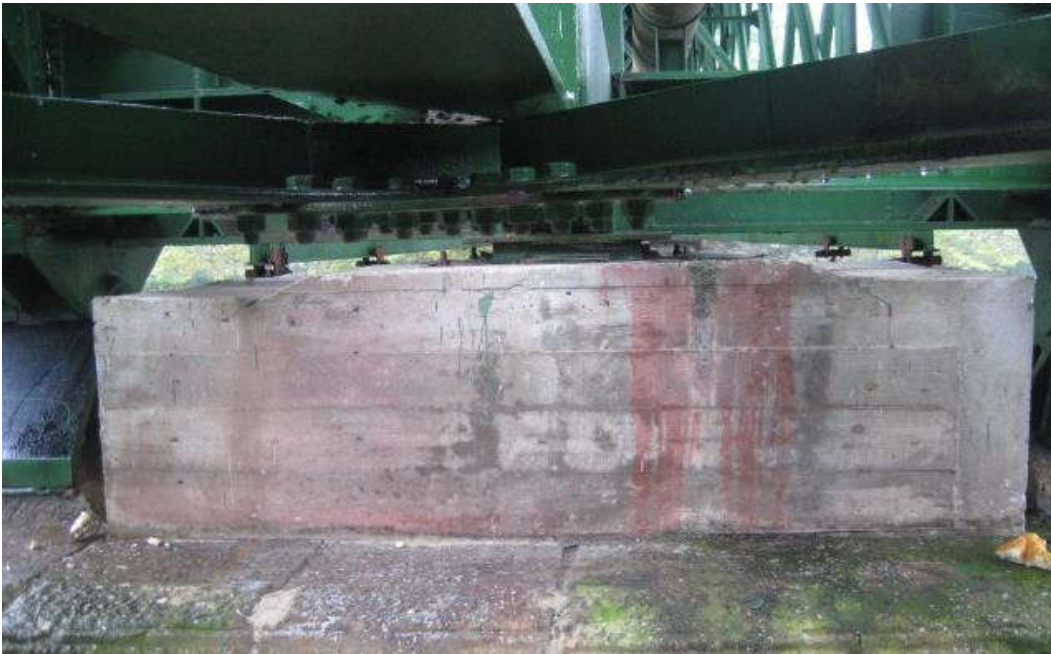
Figura 7. Cargadero de hormigón de pila 1 desde vano 2.
