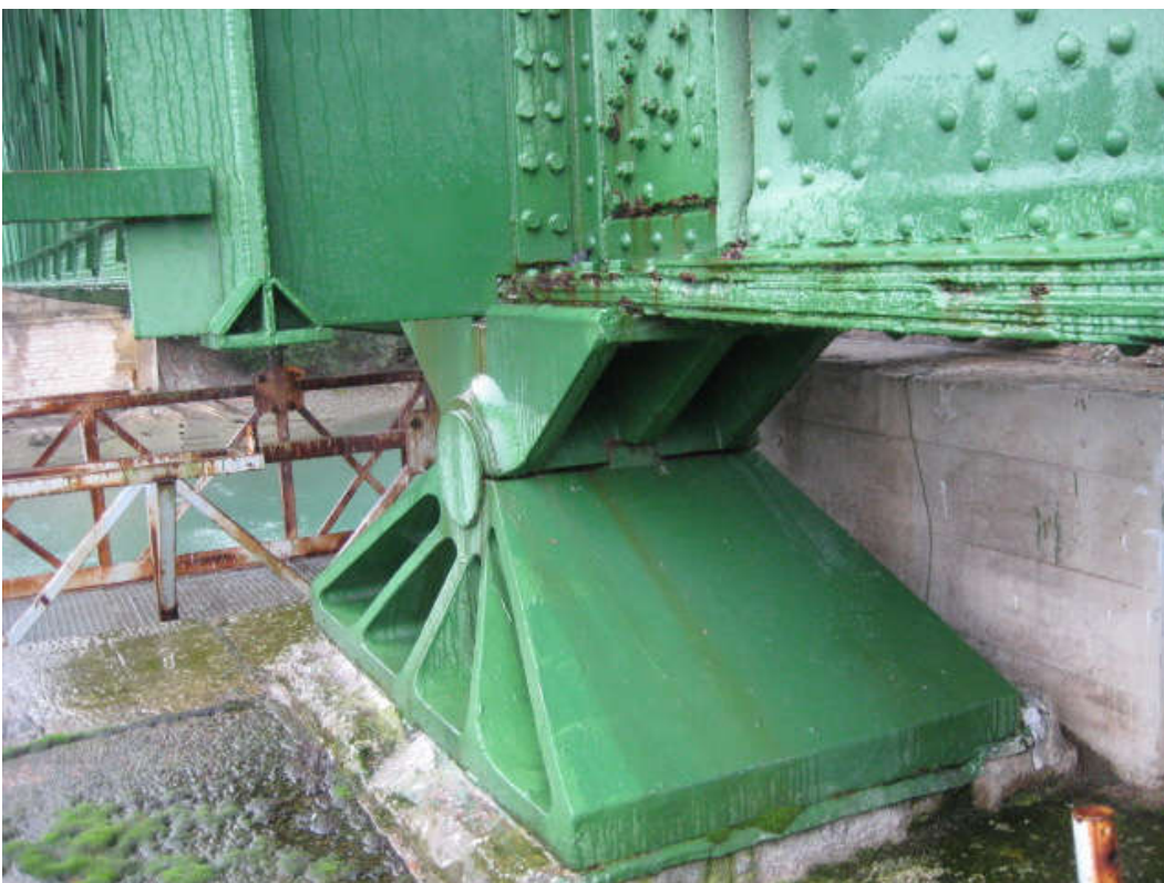
Figura 8. Aparato de apoyo izquierda de pila 1.
