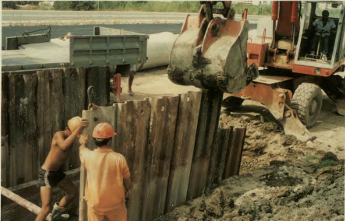
Fig. 50. Introducción de las tablestacas
