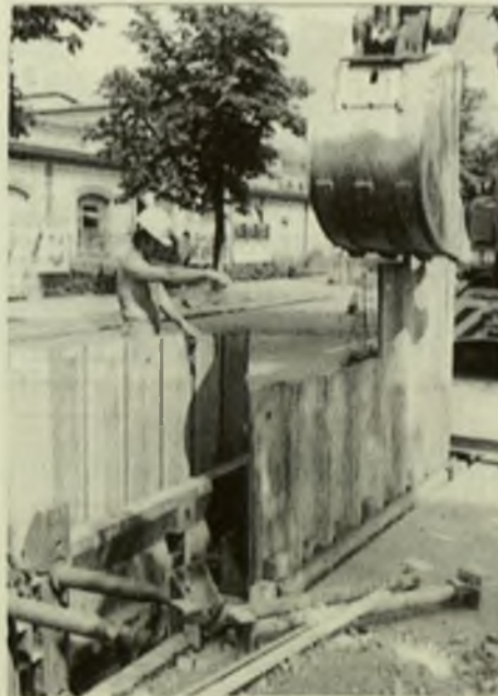
Fig. 47. Introducción de las tablestacas con la retroexcavadora
