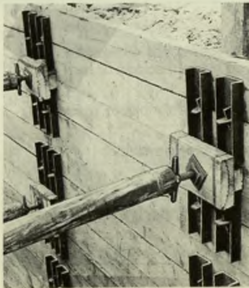
Fig. 15. Acodamiento de la entibación. Abarcando dos cerrojos a la vez
