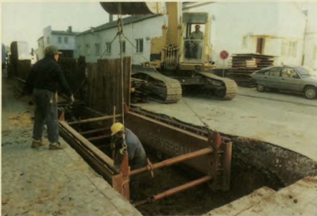
Fig. 49. Colocación del módulo de blindaje en la excavación previa
