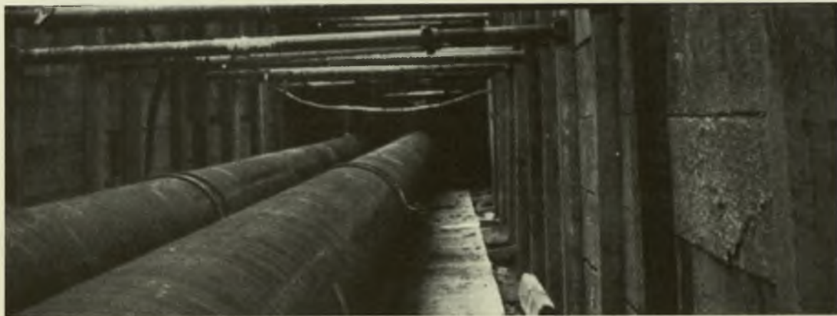
Fig. 18-A. Codales sobre tablonos
