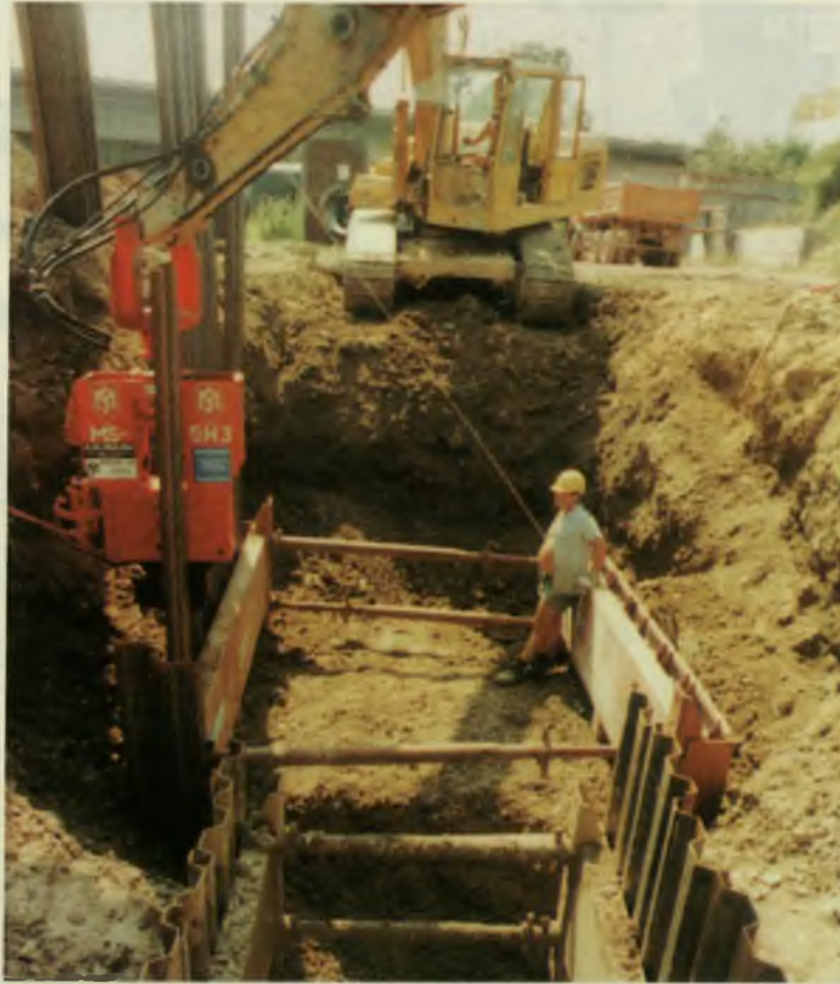
Fig. 48. Utilización de una vibradora de alta frecuencia en terrenos deficultosos
