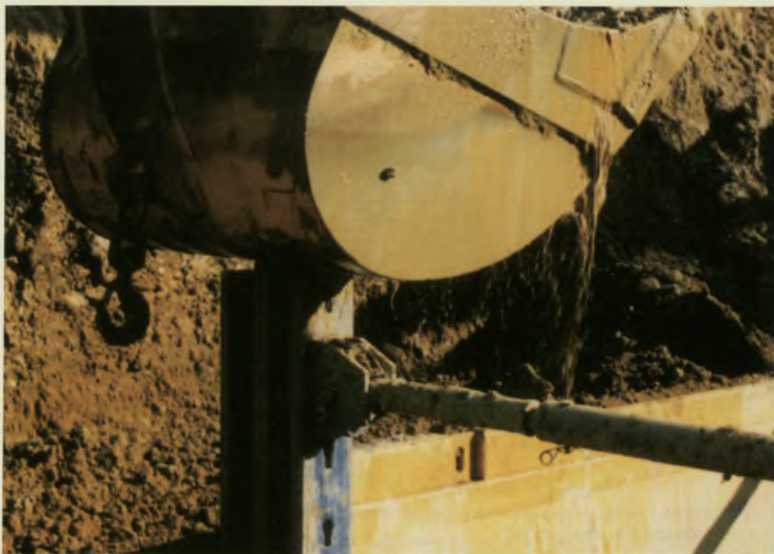
Fig. 74. Hinca de las guías mediante la excavadora
