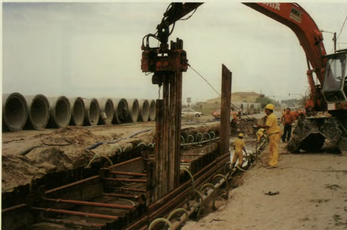
Fig. 66. Vibradora sobre tablestacas ligeras
