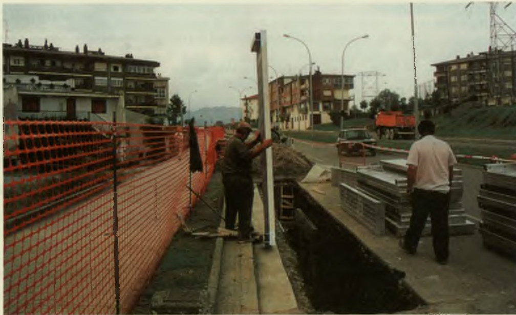
Fig. 27. Blindaje ligero de aluminio manejado manualmente
