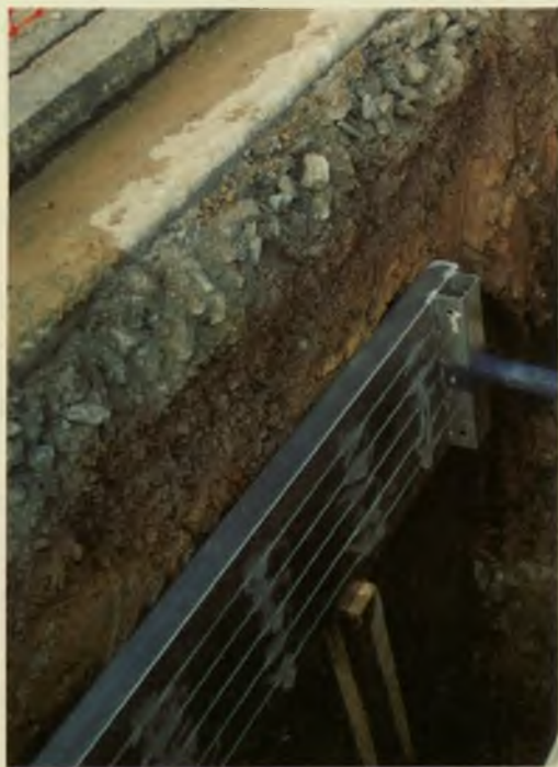
Fig. 28. Zanja con blindaje ligero de aluminio. Entibación parcial
