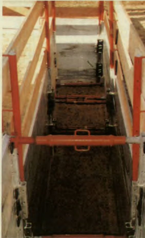
Fig. 29. Protección colectiva con balaustres y barandillas para evitar la caída de personal al interior de las zanjas
