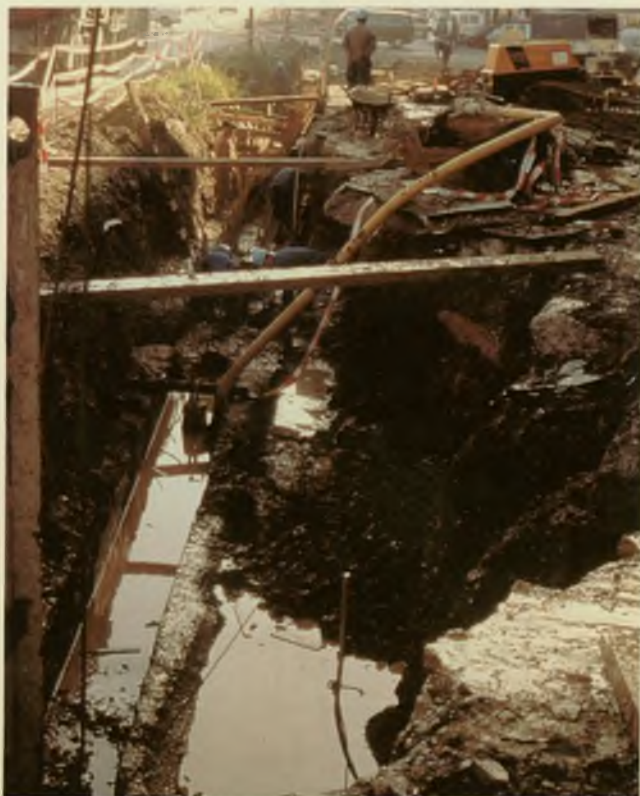
Fig. 3. Trabajos en zanjas y sus riesgos
