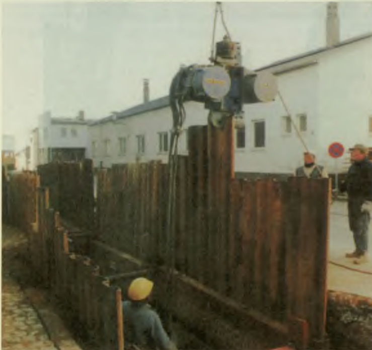
Fig. 67. Vibradora eléctrica trabajando sobre tablestacas ligeras
