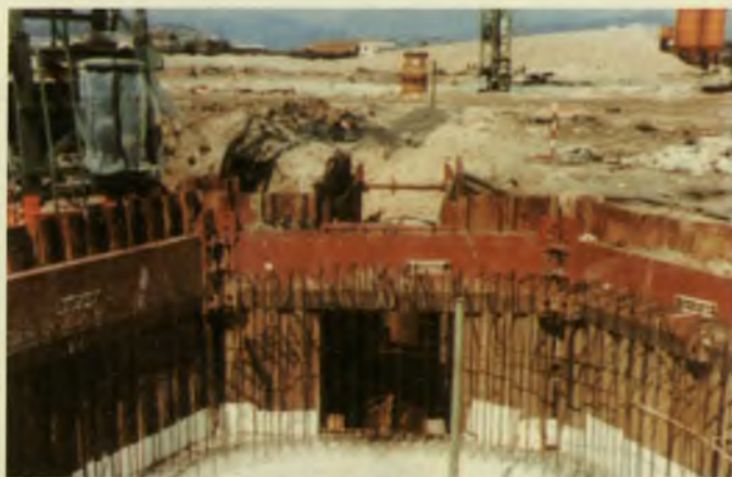
Fig. 57. Ejemplo de la utilización de tablestacas
