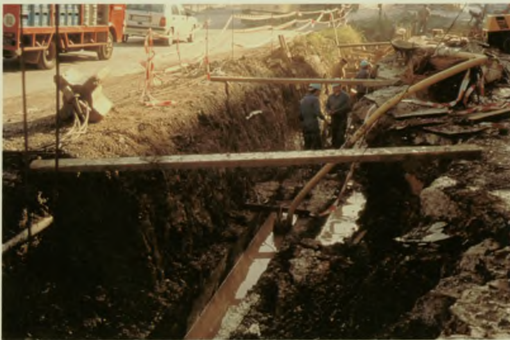
Fig. 1. Ejemplo de trabajo en zanjas en zona urbana
