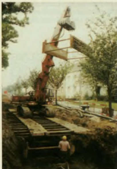
Fig. 54. Desplazamiento de la excavadora sobre una zanja ancha
