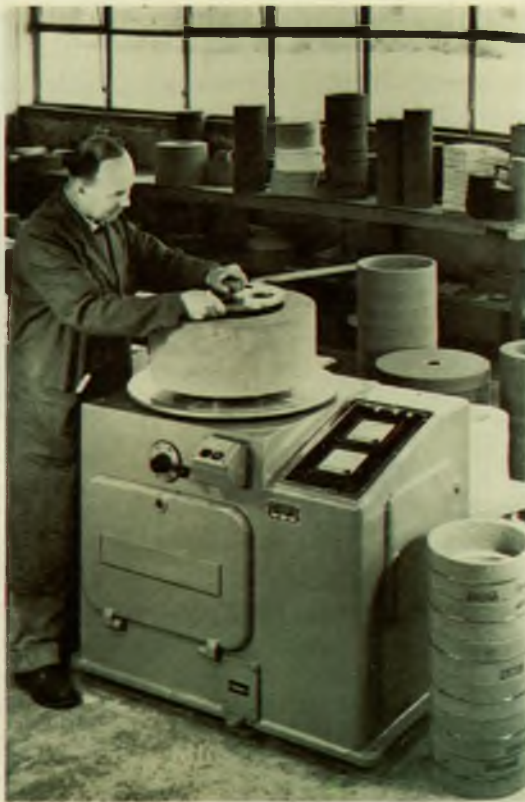
Fig. 32.—Equilibrado dinámico en máquina especial.
