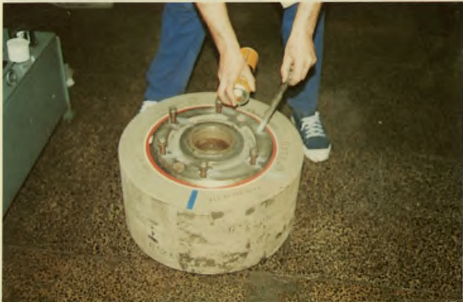
Preparación y limpieza de los tornillos de sujeción.
