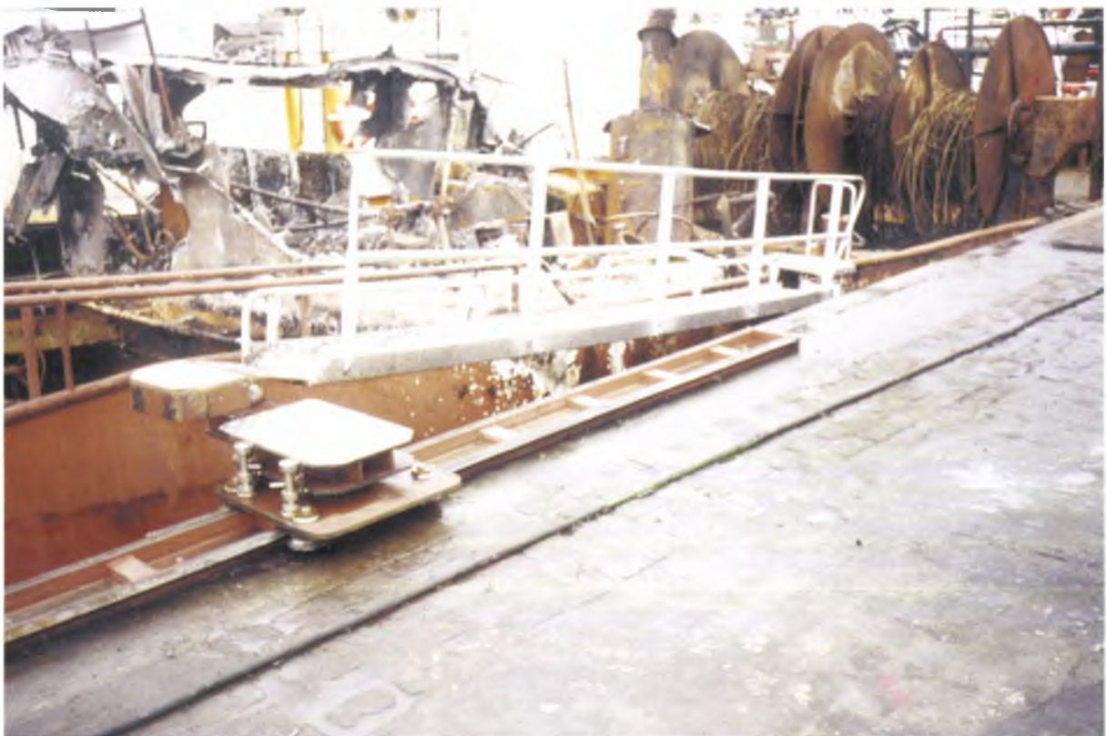
Kaian kokatutako errodadura gunearen eta arrantza-ontziaren sarrerako pasabidearen zati mugikorraren xehetasunak erakusten dituen irudia.
