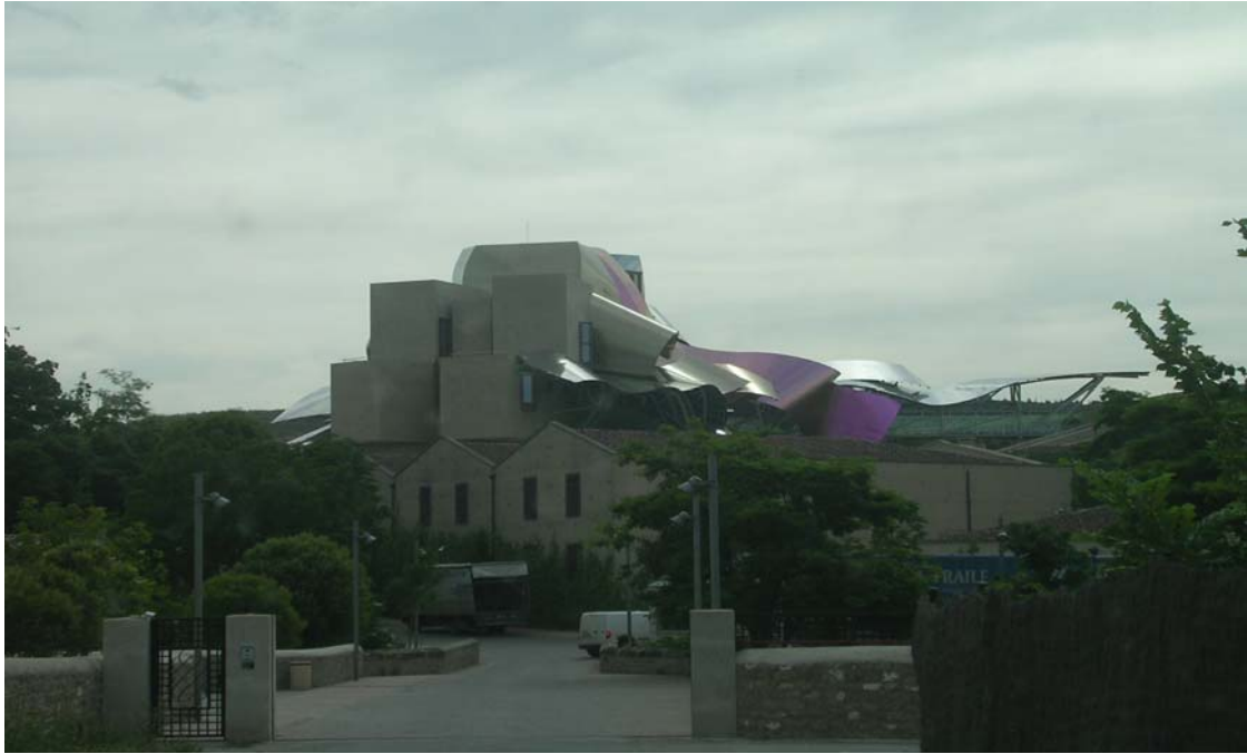
Bodega Sucesores de Marqués de Riscal (Elciego)
