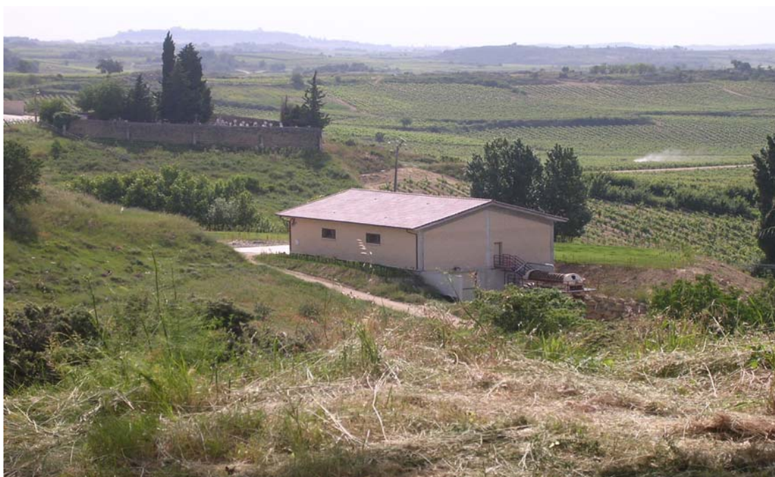
Pabellón de bodega
