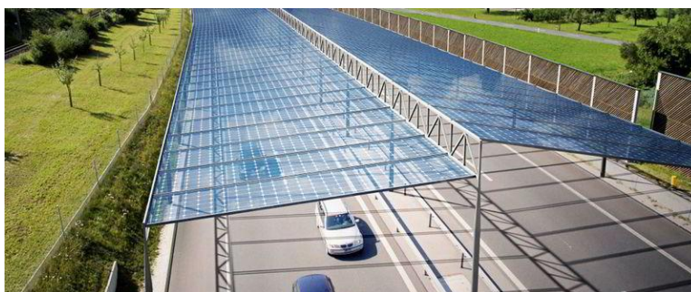
Graf 15. Esquema de pérgolas solares sobre autovías, en estudio por el Instituto Fraunhofer para Sistemas de Energía Solar, en Alemania
