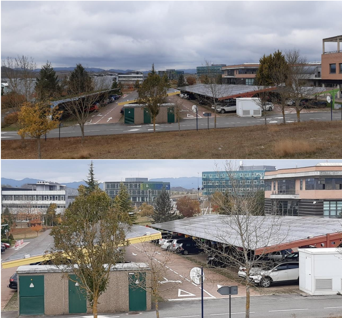
Graf 17. Ejemplo de instalaciones de generación fotovoltaica sobre los aparcamientos en el Parque Tecnológico de Álava
