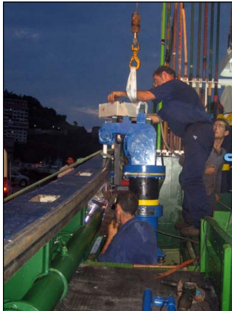
Figura 13: Operaciones de instalación a bordo
