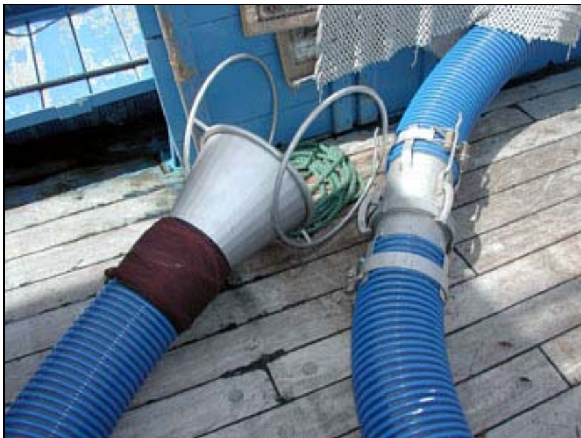
Figura 9: Boca de aspiración y acoplamientos
