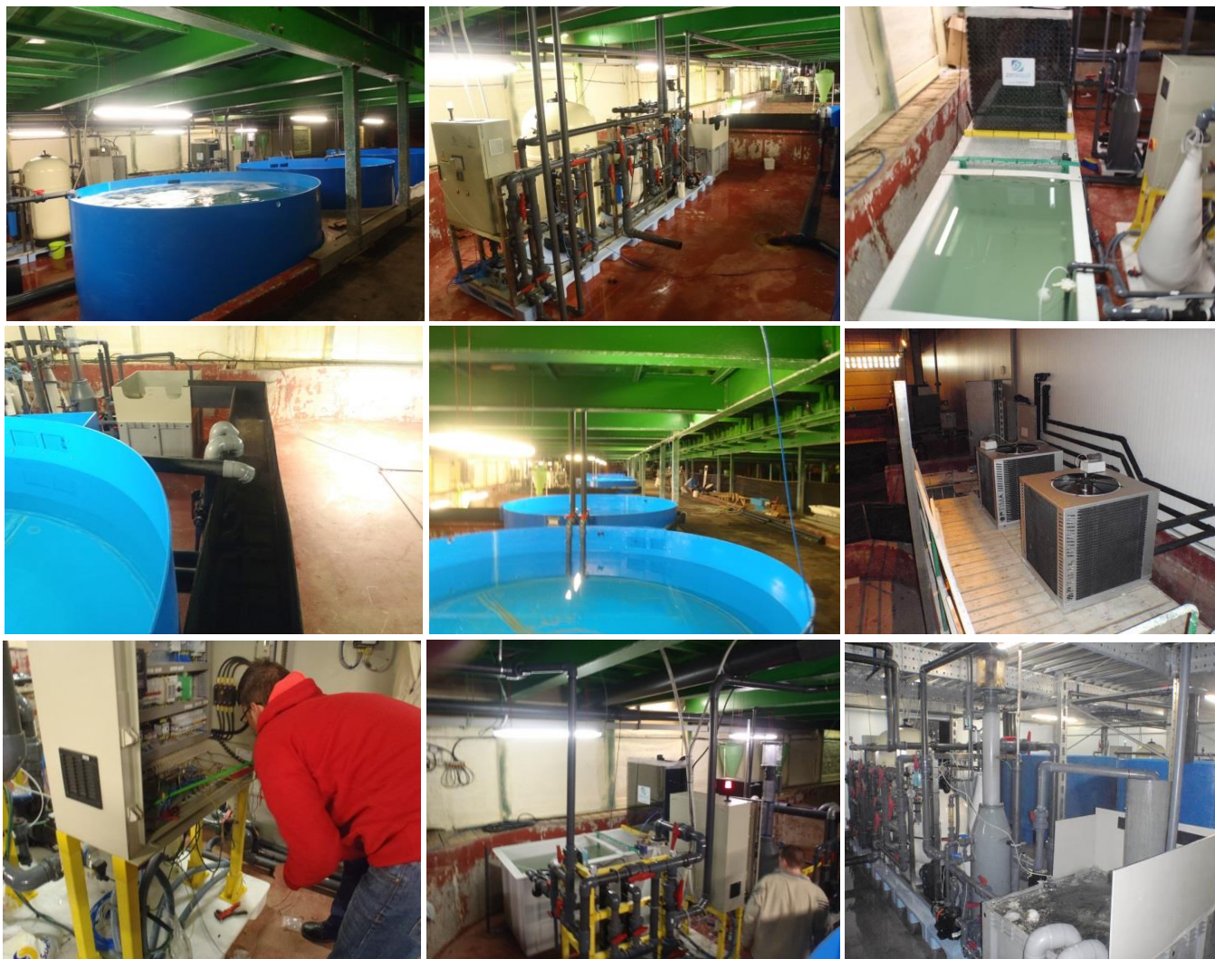
Fig.11. Detalles de la instalación realizada en la planta de debajo de la piscifactoría de Orrua para el cultivo de salmón. Se trasladaron y reconstruyeron 6 tanques, 2 (+1 nuevo) módulos con componentes de desinfección y control térmico del agua y variables mediante sistemas automátata; también se realizaron, varios trabajos de re-canalización de agua.
