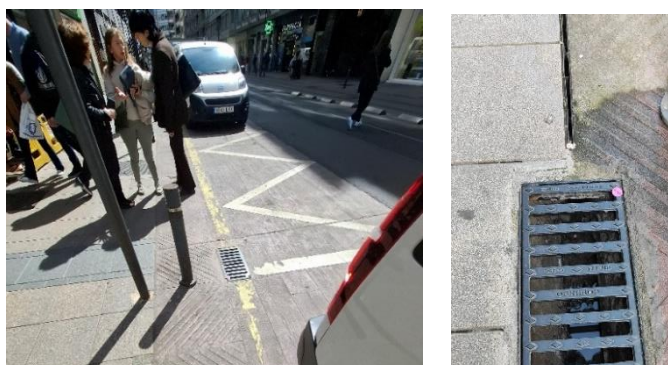
Drenaje mediante sumidero/rejilla metálica no oculta
