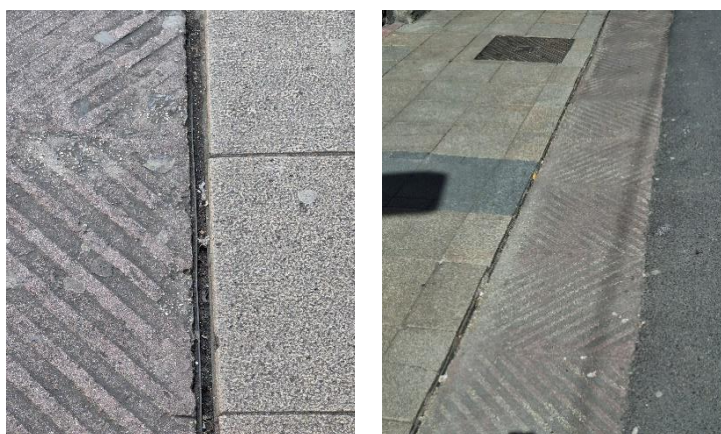
Drenaje mediante rejilla ranurada lineal oculta
