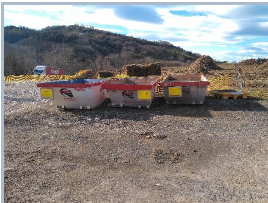
Ilustración 4. Acopios de residuos no peligrosos en obra y cubeto de retención de emergencia.
