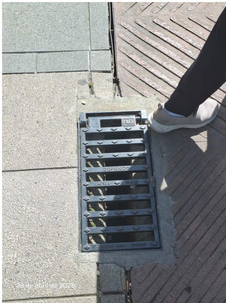
Foto nº 5: Detalle de urbanización, delimitación entre zona peatonal y plataforma tranviaria
