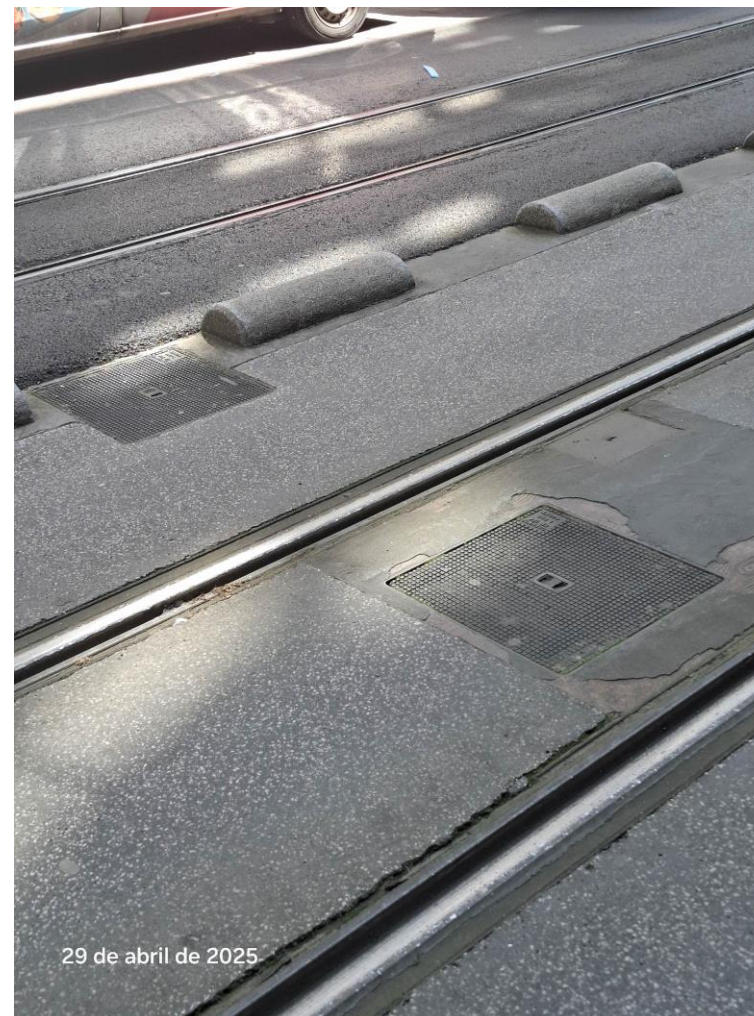
Foto nº 20: Detalle de la plataforma tranviaria. Bordillo delimitador
