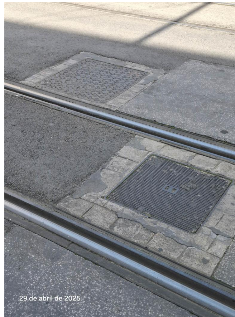
Foto nº 16: Detalle de urbanización (restos de hormigón impreso de la pavimentación inicial).
