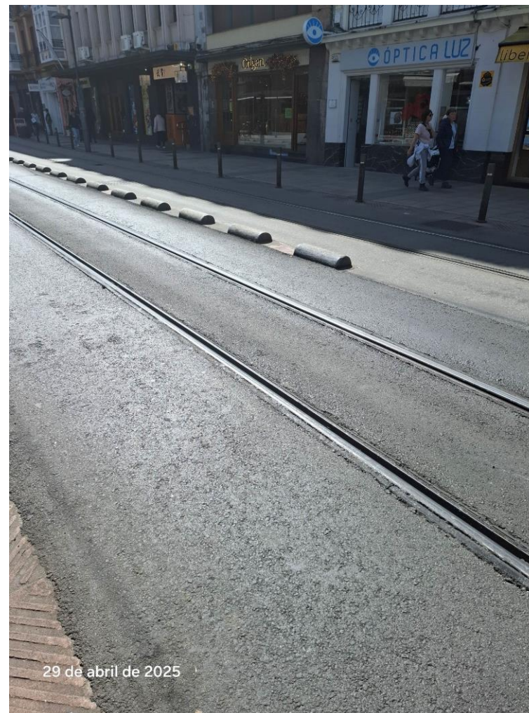
Foto nº 6: Detalle de C/ General Álava. Bordillo delimitador
