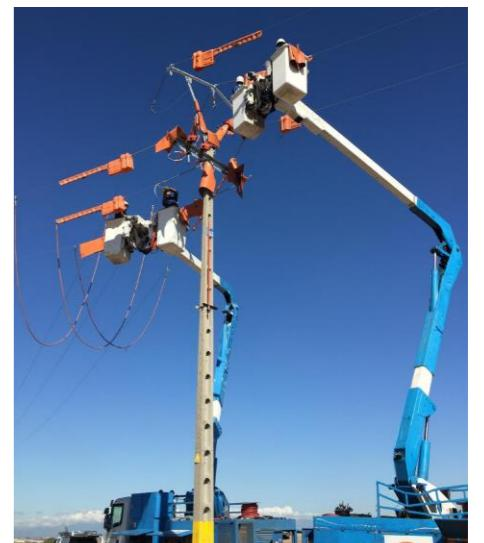
En este Método el trabajador entra en contacto eléctrico con el elemento en tensión de la instalación en la que trabaja, poniéndose a su mismo potencial, al igual que hace un pájaro que se posa en una línea eléctrica.
