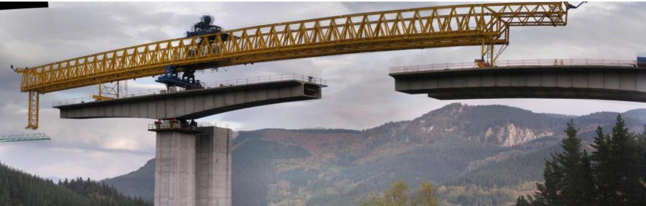
El sistema constructivo de dovelas prefabricadas consiste en la formación del tablero mediante la unión de elementos obtenidos al cortarle por planos perpendiculares a su eje, en el que cada elemento tiene la sección transversal completa del tablero
