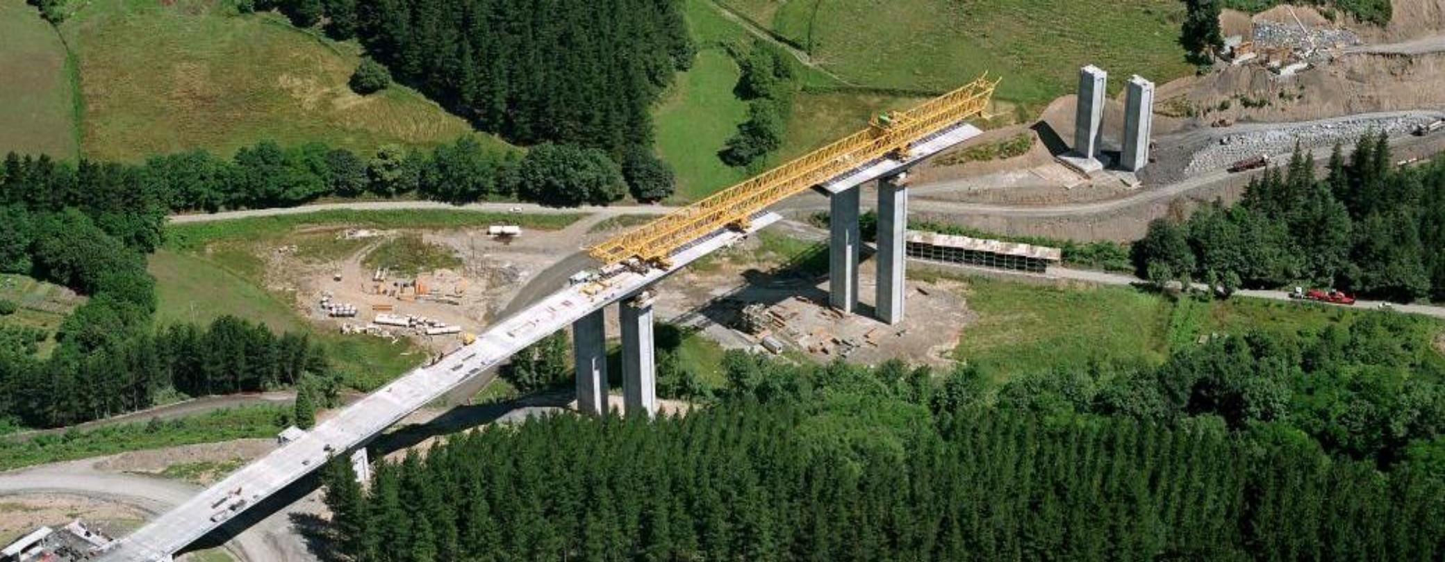
Al requerir equipos de fabricación y montaje más potentes, el sistema de dovelas prefabricadas está indicado para viaductos de gran longitud que permitan la amortización de los equipos
