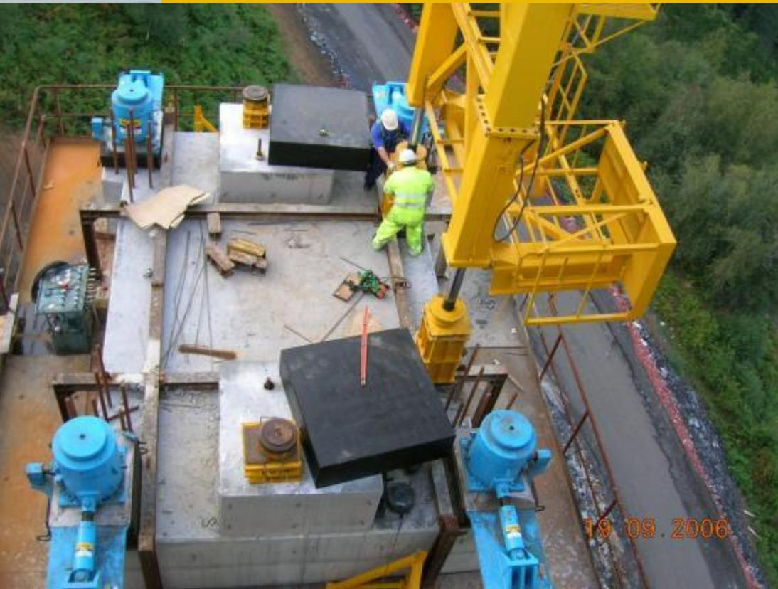
El perímetro del estribo o tablero desde el que se lanza y la cabeza de la pila destino del lanzamiento estarán protegidas
