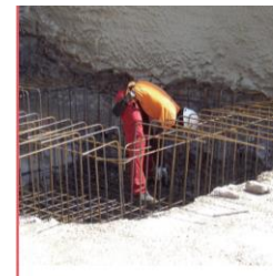
Posturas forzadas y aplicación de fuerza durante el atado de ferralla
