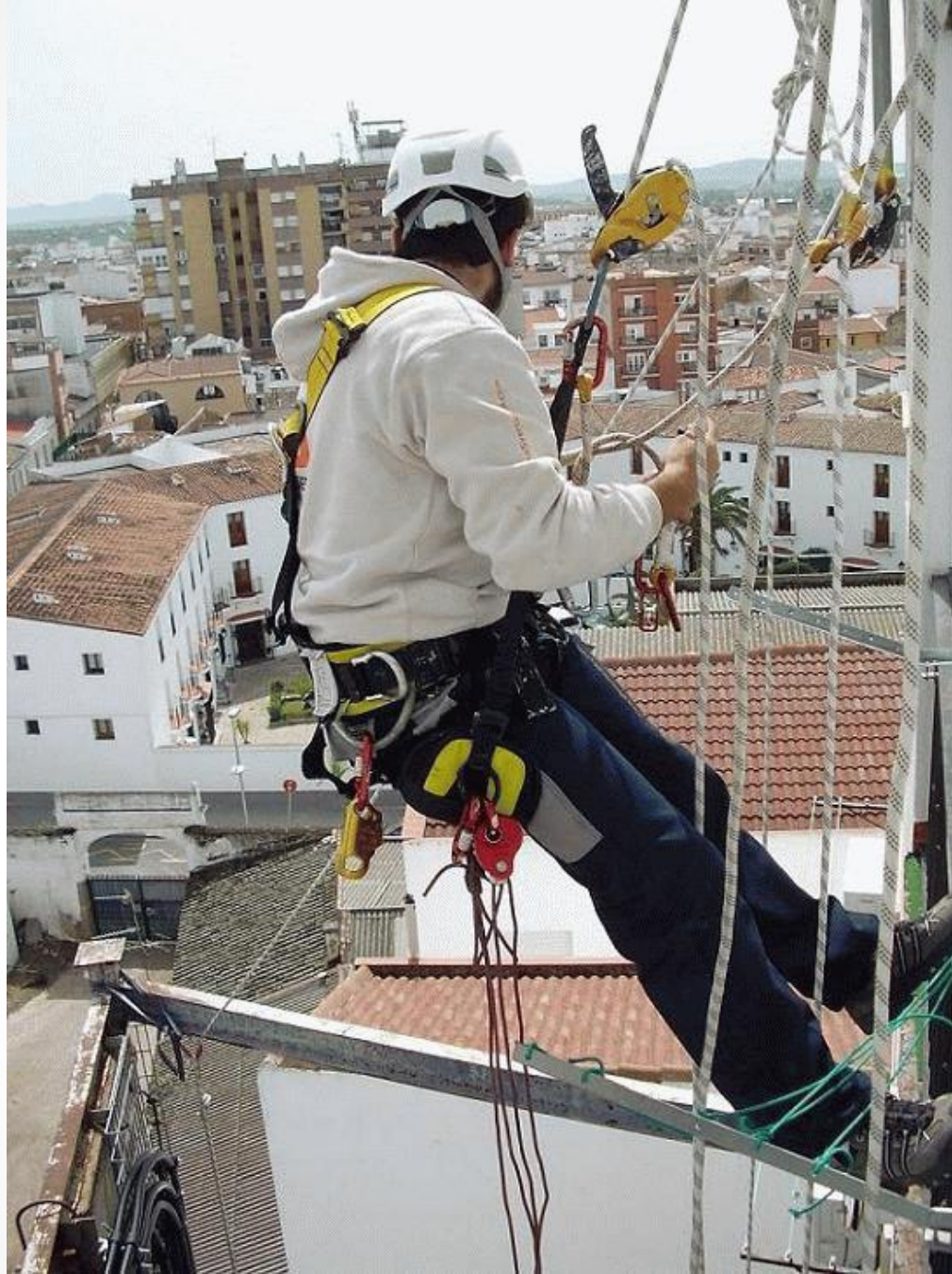
Trabajos con riesgo
