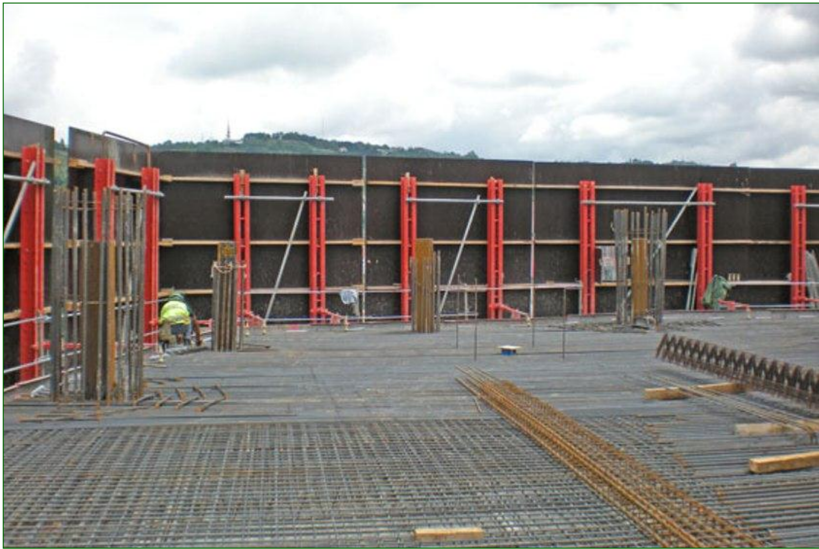
Vista de la protección perimetral desde el interior del forjado.
