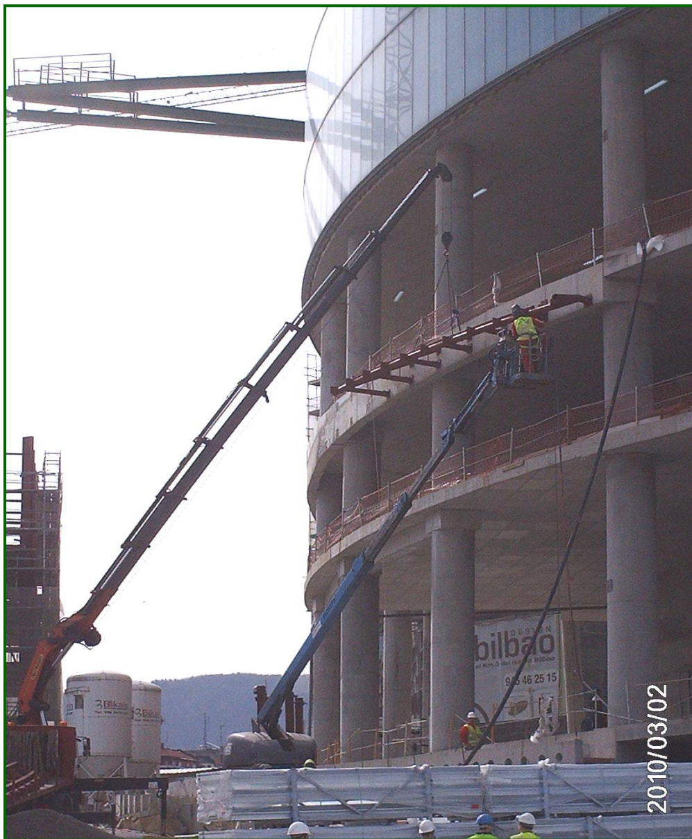
Colocación de soportes del lobby mediante plataforma elevadora.
