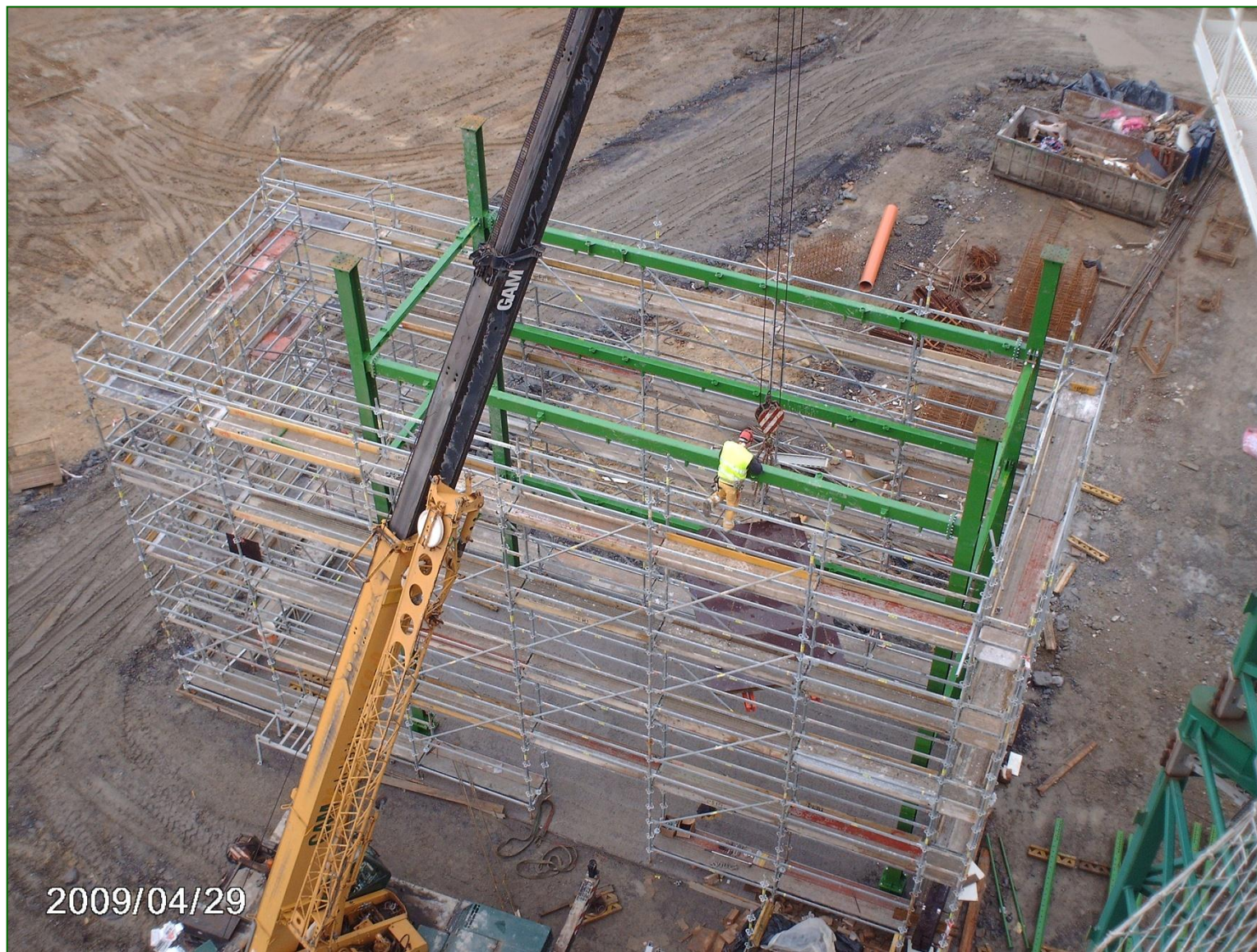
Dársena de montaje de la estructura de los ascensores y montacargas de obra.
