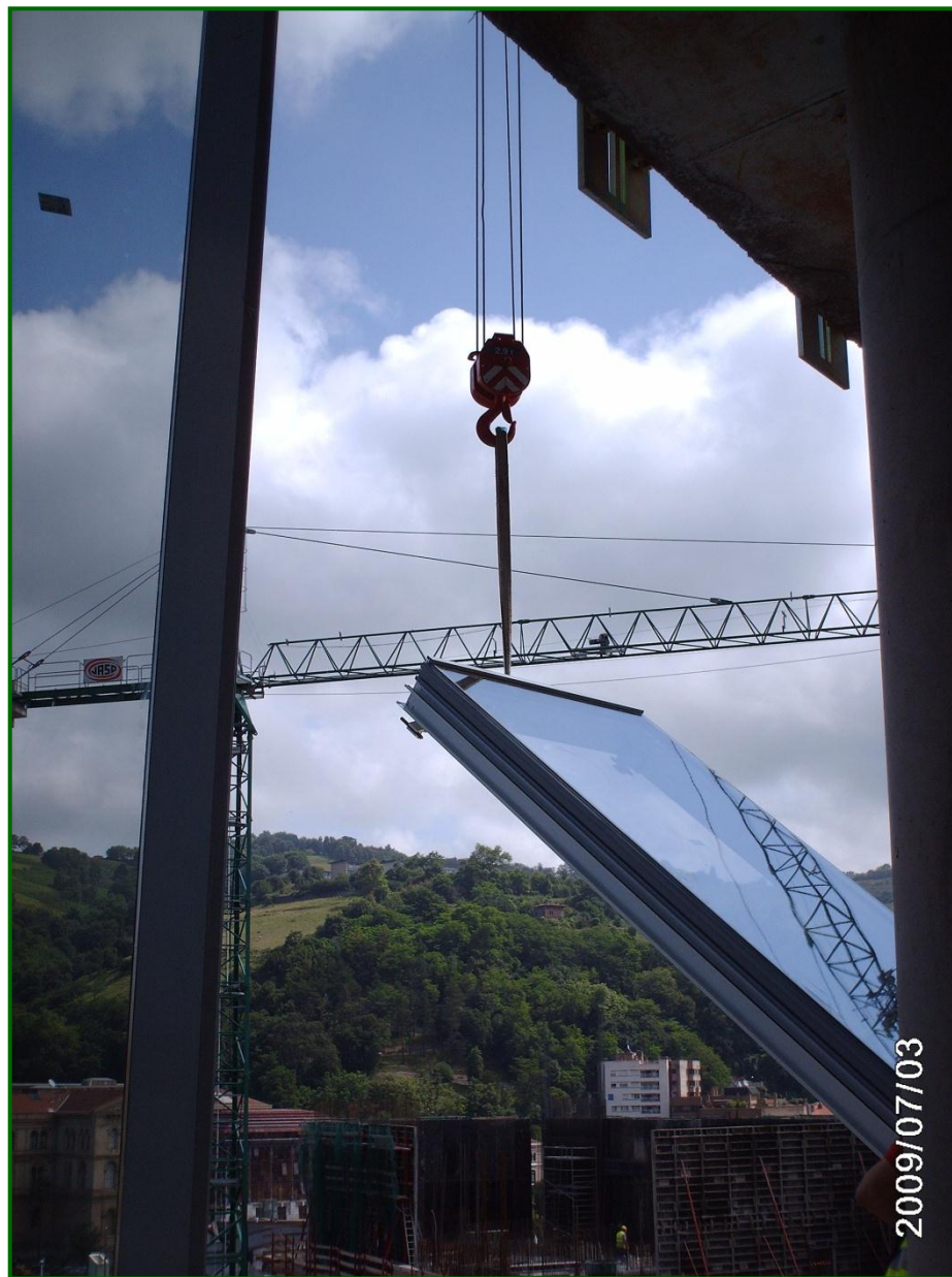
Detalle de módulo izado mediante cabrestante.
