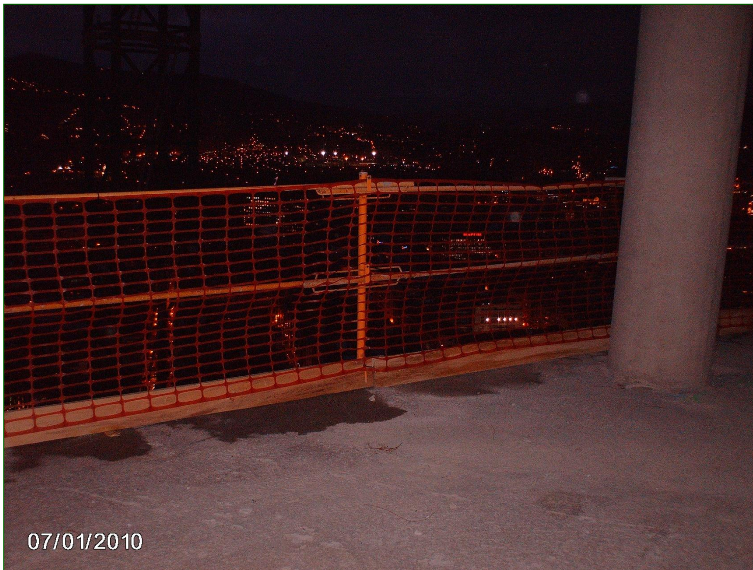
Barandillas de seguridad en borde de forjado con rodapié y malla stopper.
