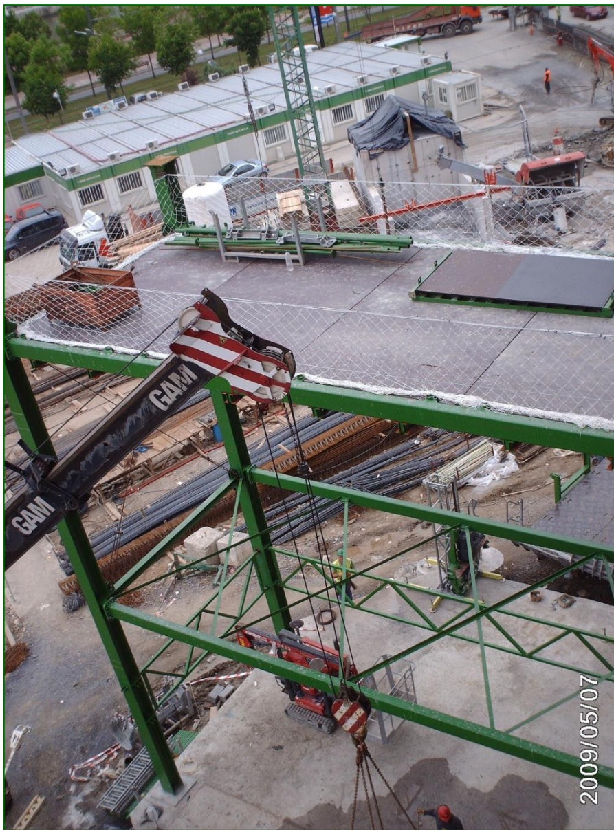
Colocación del primer módulo de la estructura de los ascensores de obra.
