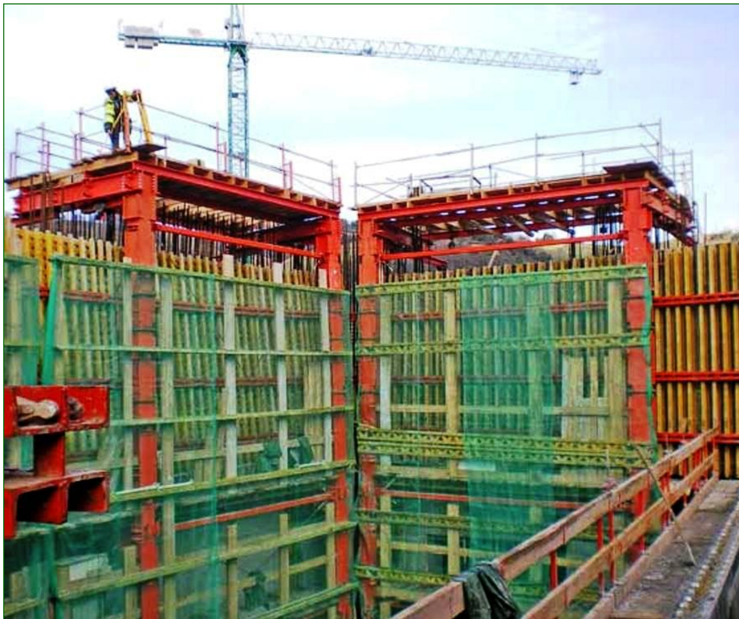
Encofrado autotrepante (autotrepa).
