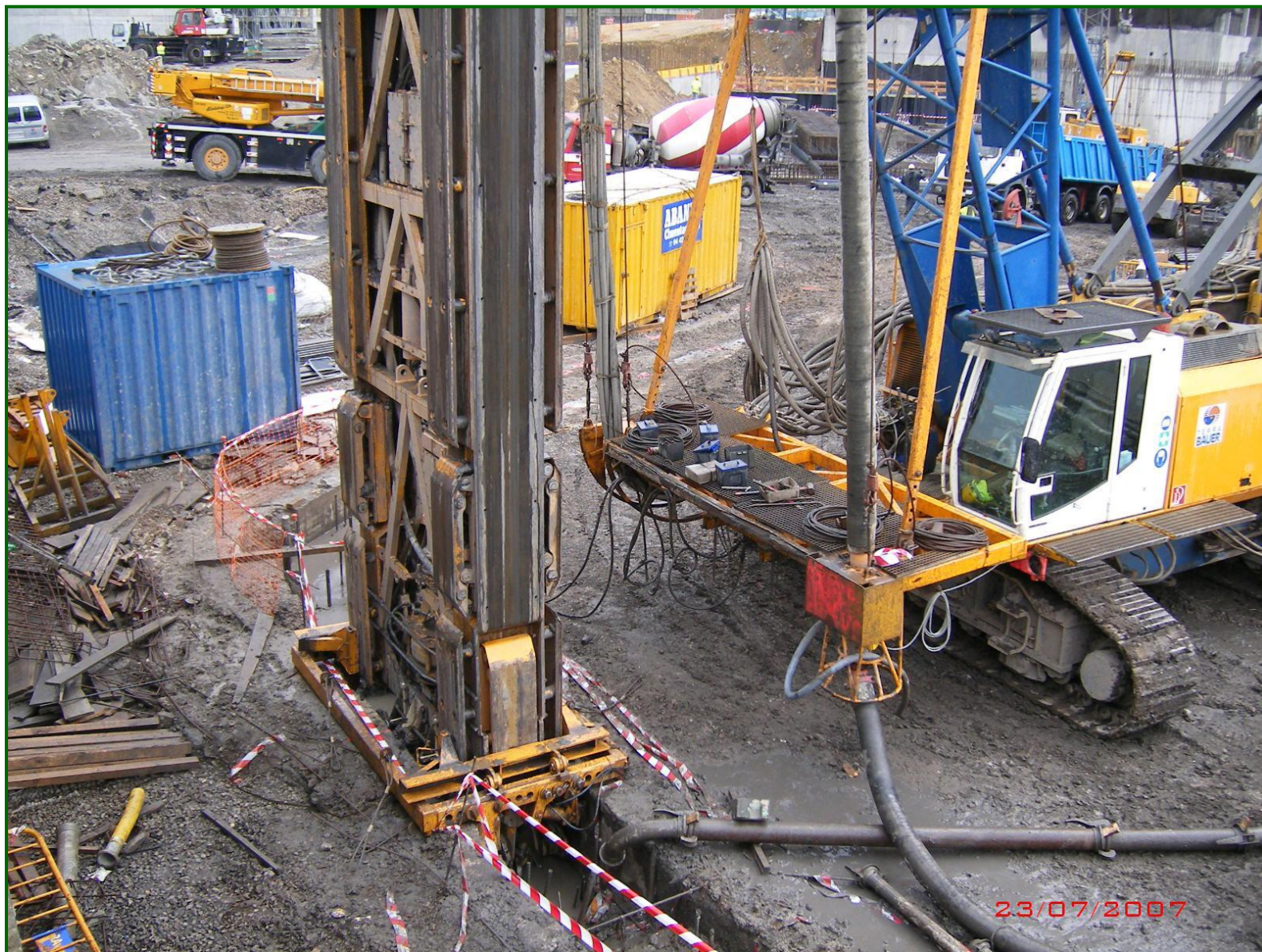
Hidrofresa excavando murete guía.
