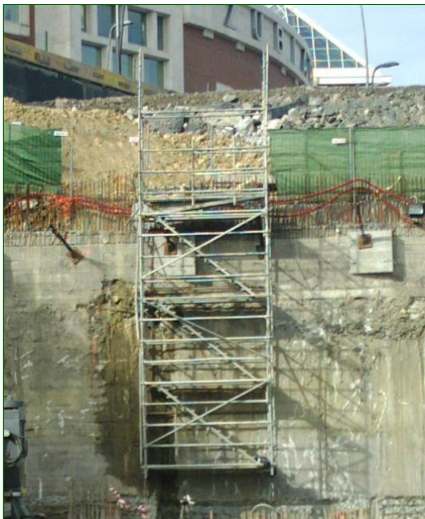
Estructura tubular de acceso con losa hormigonada
