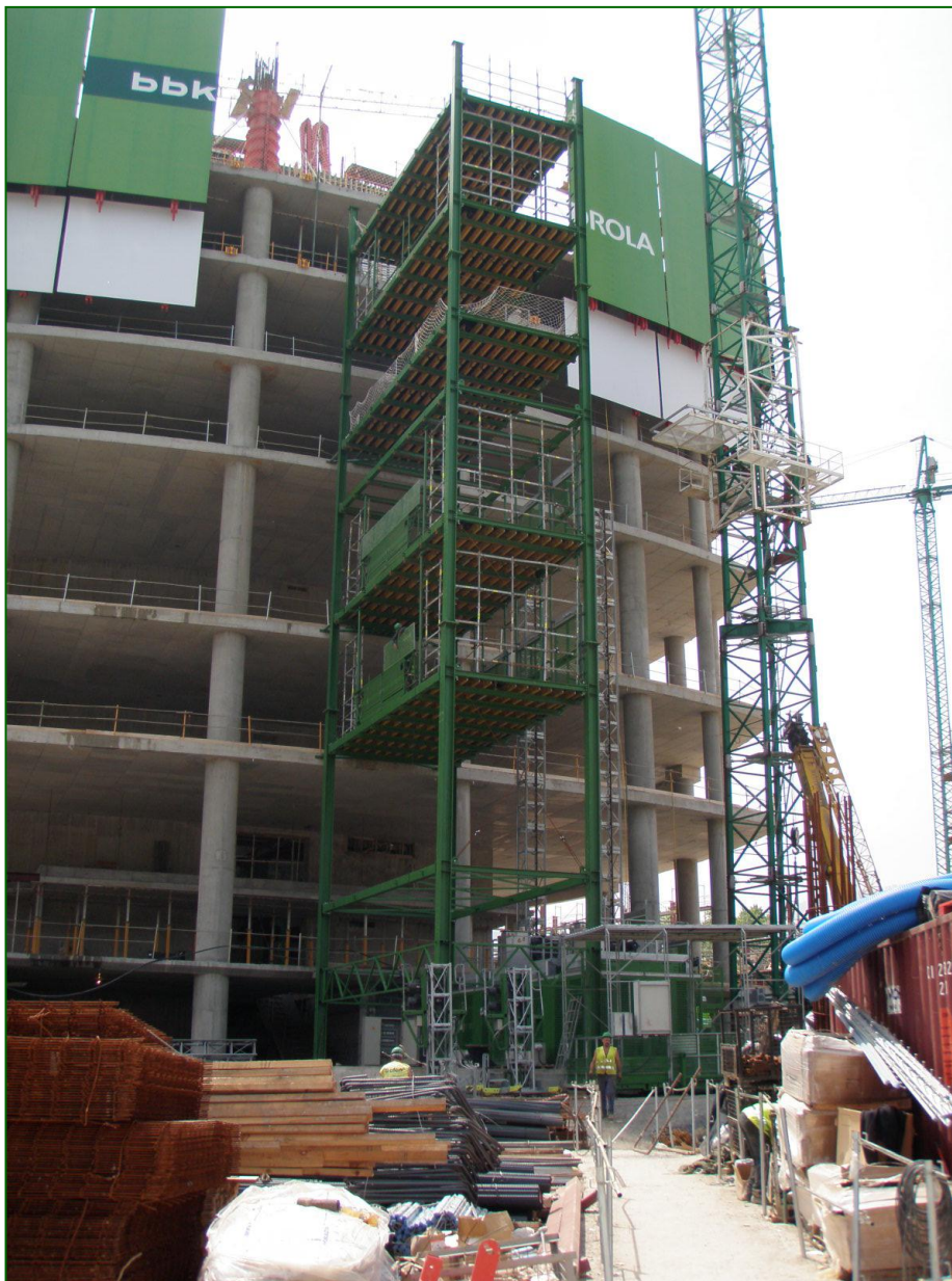
Primeros módulos de ascensores y vía de acceso.
