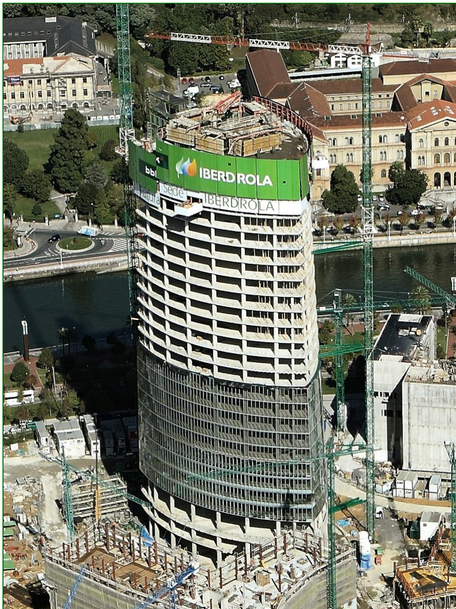
Vista de la protección perimetral desde el exterior.
