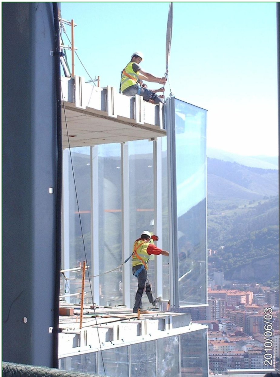
Colocación de módulo de esquina.
