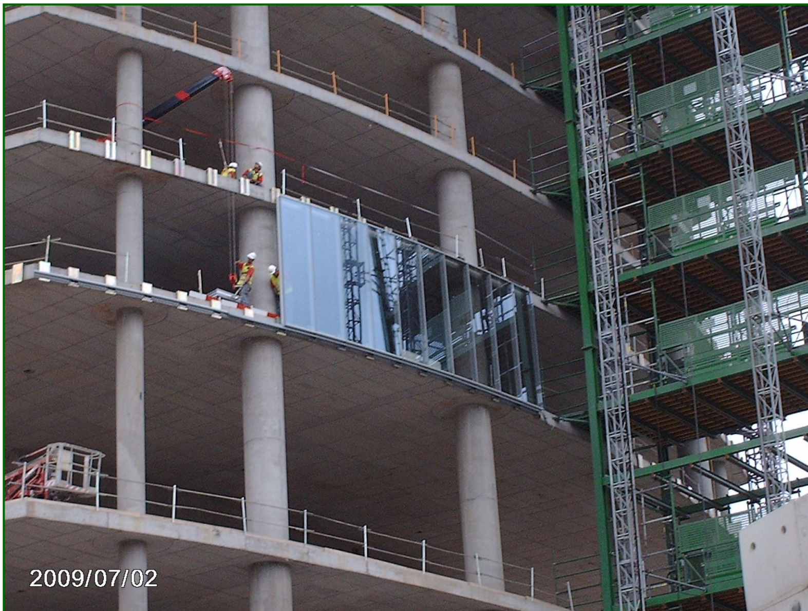
Montaje de módulos de fachada con cabrestante.
