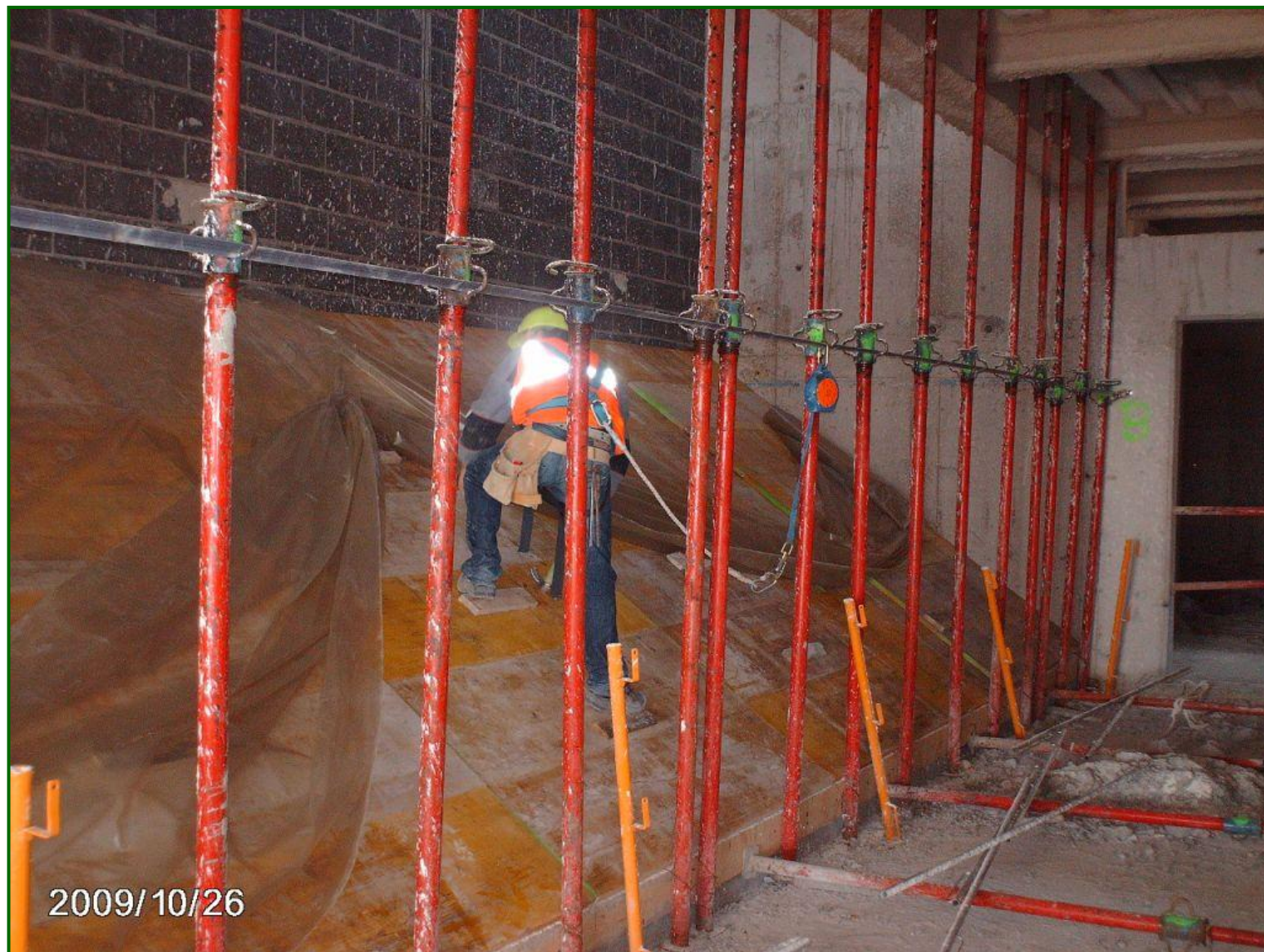
Tapón de seguridad apoyado en hueco de ascensores.
