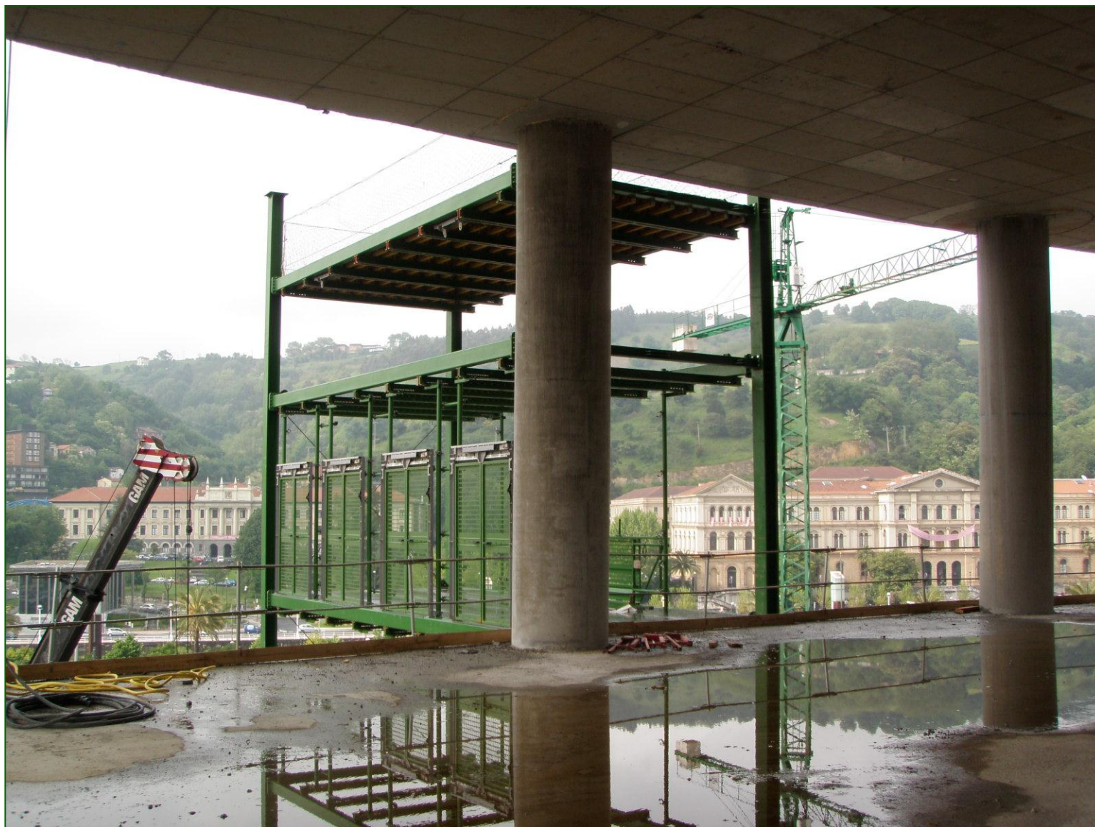
Desembarco del primer módulo de ascensores.
