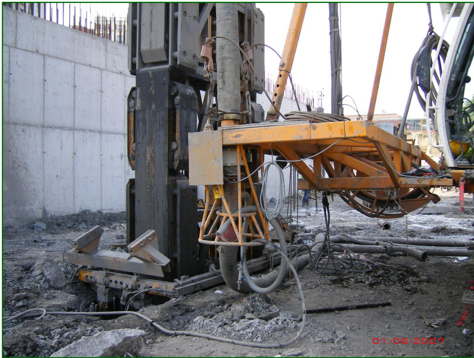
Hidrofresa excavando murete guía.
