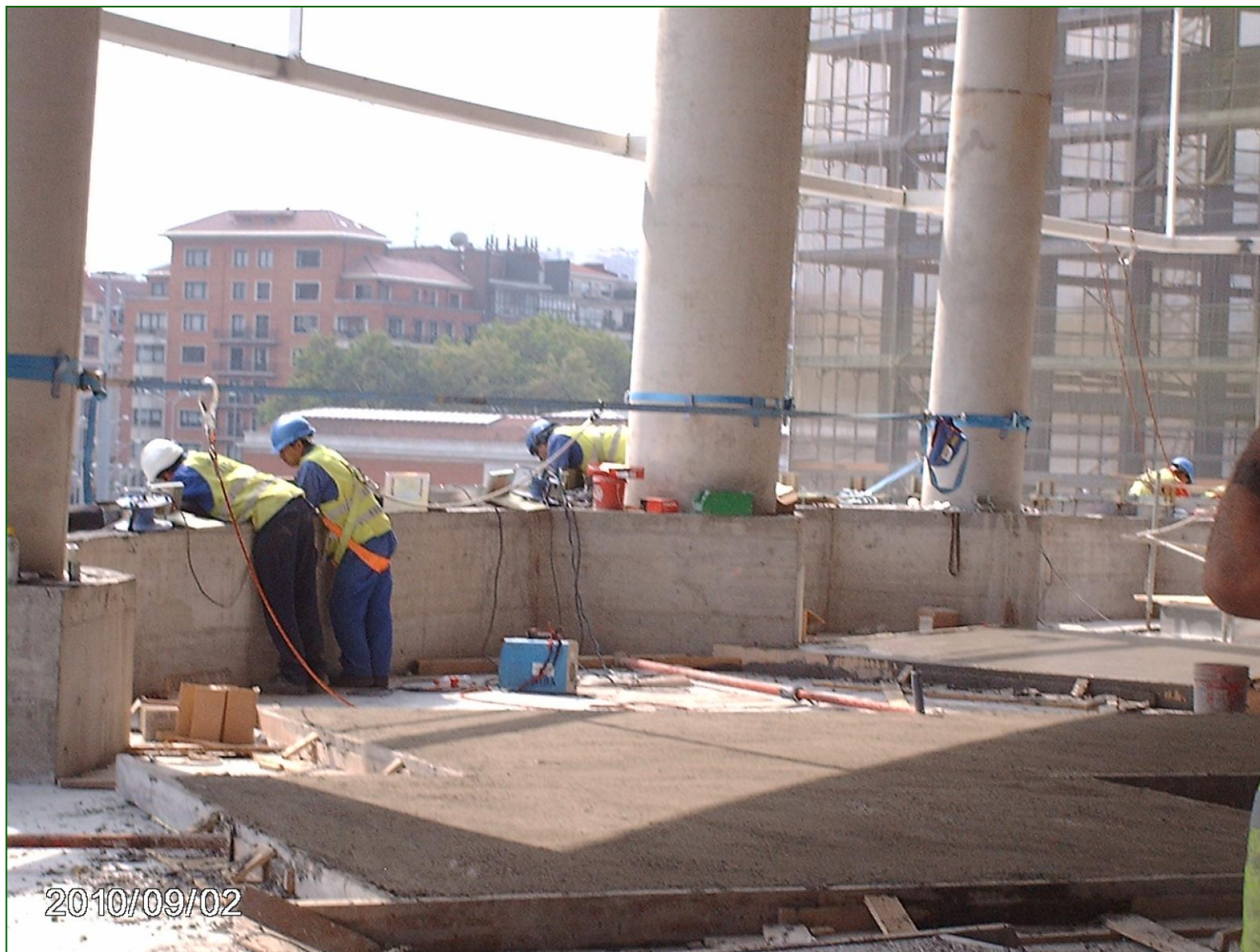
Sistema de línea de vida a pilares definitivos para montaje del lobby.
