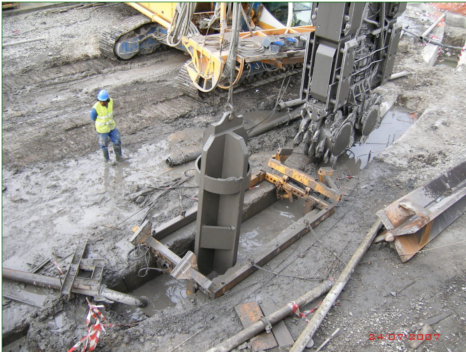
Conjunto trépano (izq) + hidrofresa (drcha).
