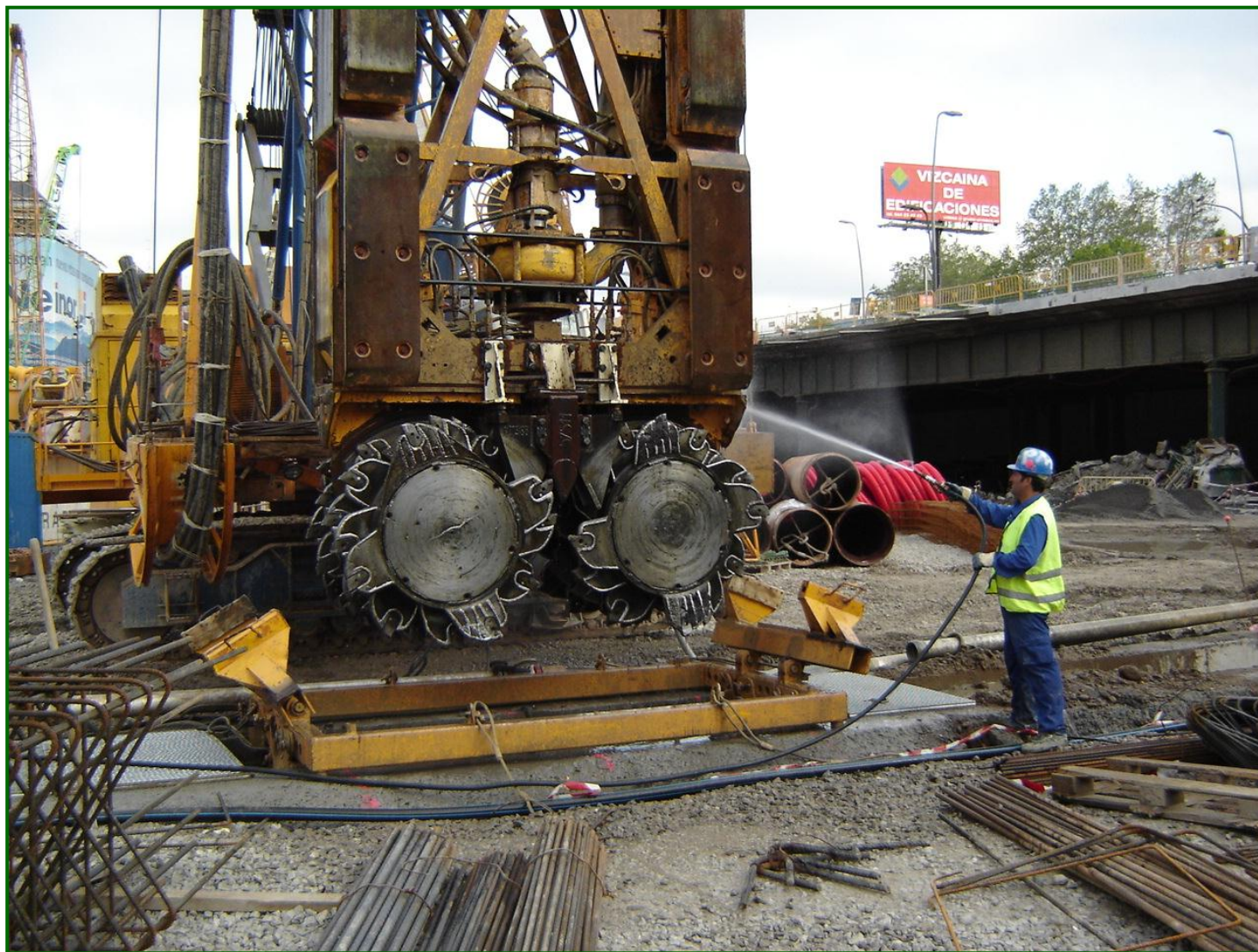
Limpieza de cabezales.
