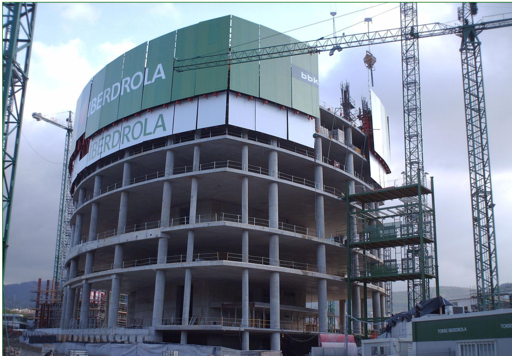
Vista de la protección perimetral desde el exterior.
