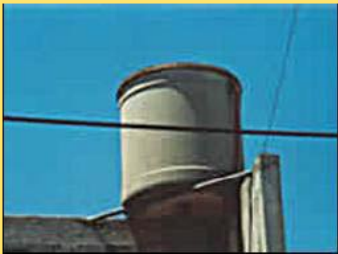
Tanque de agua
