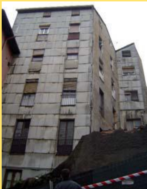
Paramentos de fachadas
