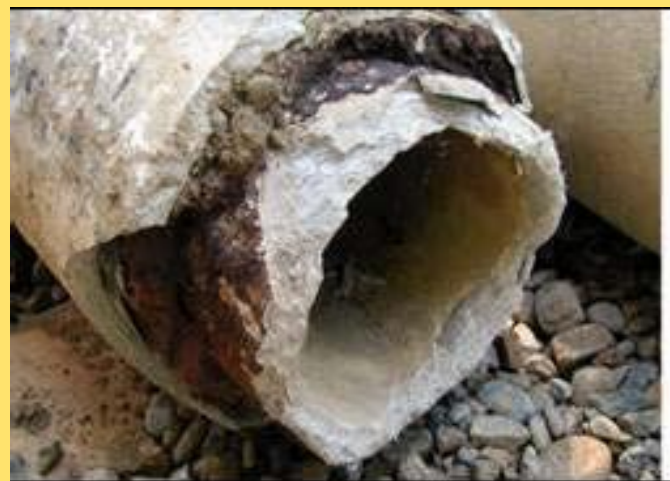
Tubería de fibrocemento
