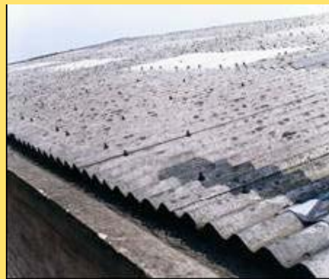
Planchas onduladas en techo
