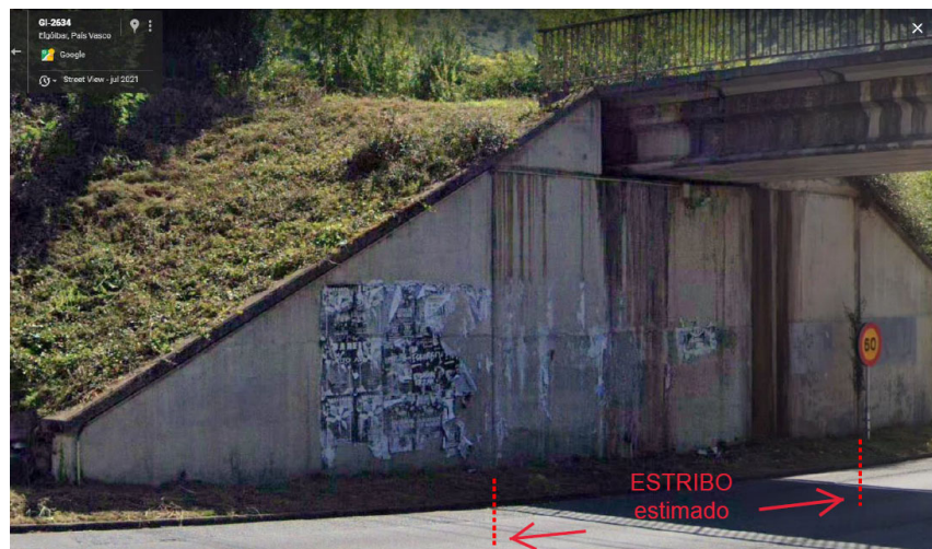
Vista de estribo existente
