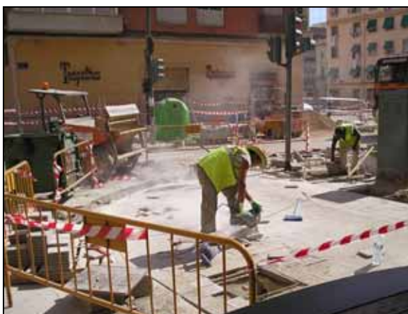
Figura 4.10. – El corte de material en seco produce una emisión alta de PM 10
