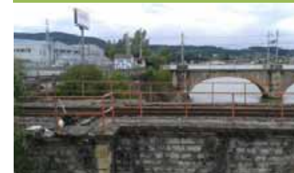
PUENTE ffcc ETS SOBRE BIDASOA
