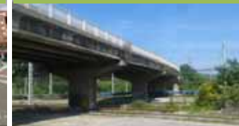
PUENTE SOBRE EL FERROCARRIL
