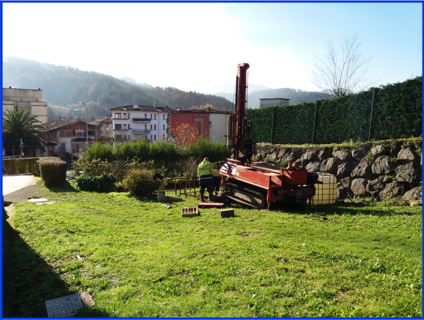
SITUACIÓN SONDEO S-1
