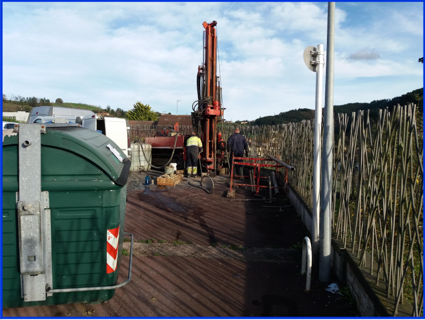
SITUACIÓN SONDEO S-4
