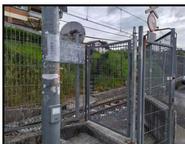
Imagen 1 Acceso sur al paso a nivel
