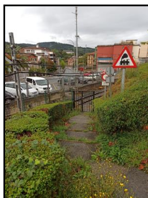
Imagen 3 Acceso norte al paso a nivel
