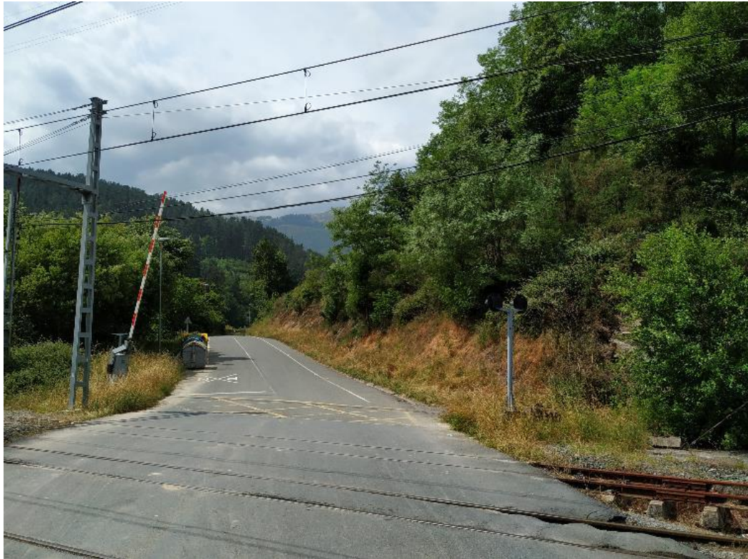
Carretera BI-4337 margen oeste
