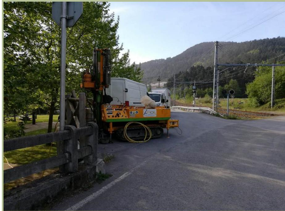
El sondeo se ha perforado en la única zona donde ha sido posible emplazar máquina y no afectar a los servicios soterrados existentes.
