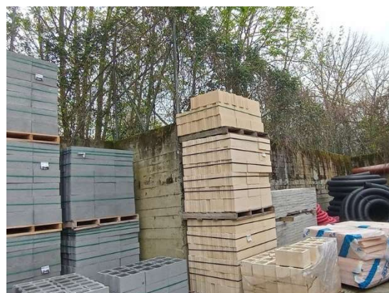
Extremo Oeste del muro de Big Mat, desde el interior de la propiedad.
