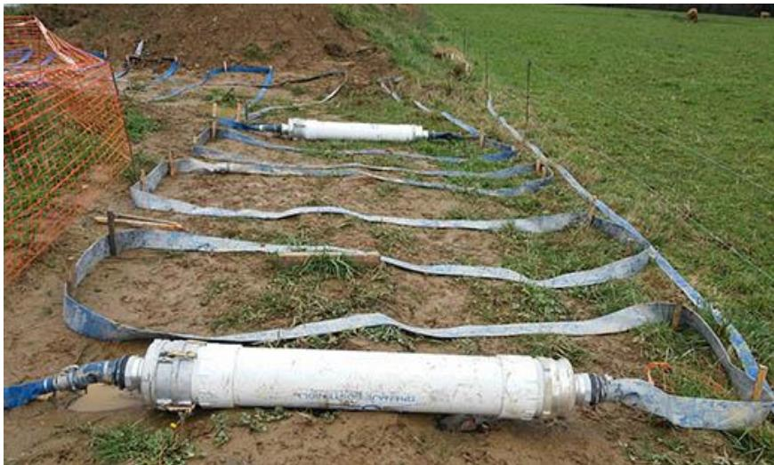
Posteriormente se hará pasar el agua por una zanja con grava y geotextiles filtrantes con una pendiente casi nula donde el agua irá a una velocidad muy baja produciéndose la decantación de los sólidos en suspensión. Se realizarán labores de mantenimiento y limpieza de la zanja de manera periódica.
