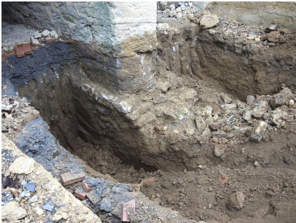
Figura 39.- Cimentación de las pilas de la alcantarilla de la margen izquierda
