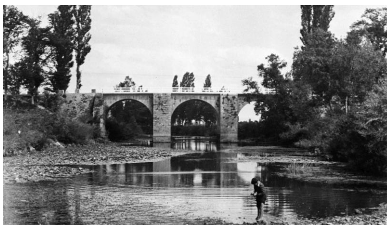
Figura 62.- Alzado aguas abajo del puente ampliado
