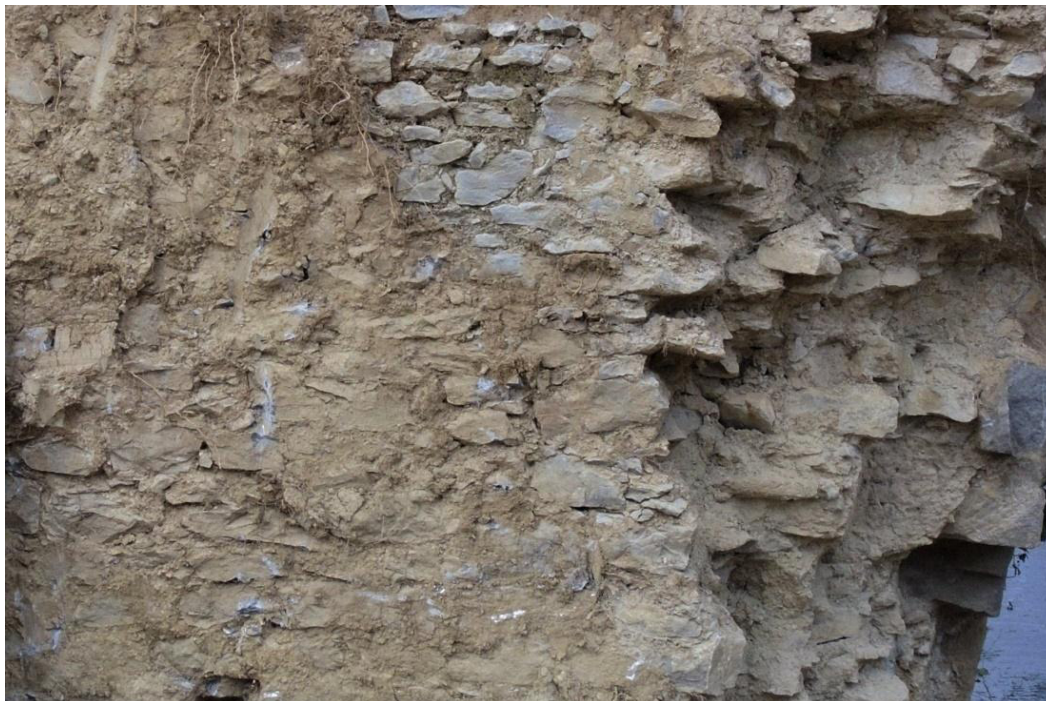
Figura 20.- Relleno de piedras de caliza margosa local y argamasa de cal del estribo izquierdo
