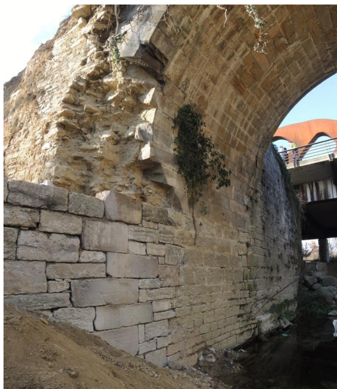
Figura 55.- Reconstrucción del encuentro de la aleta con el cuerpo del estribo izquierdo
