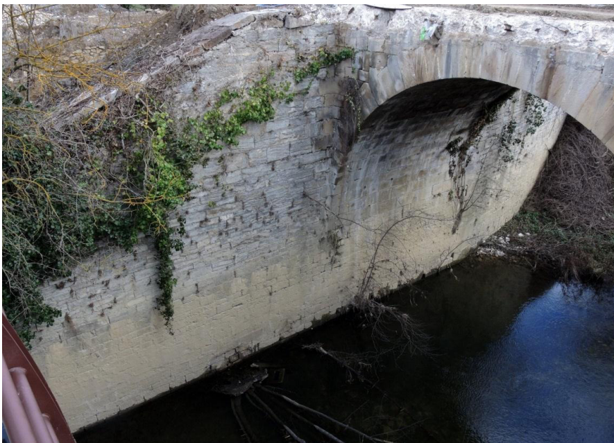
Figura 35.- Aletas del estribo derecho
