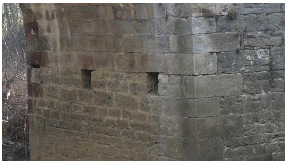
Figura 19.- Huecos de apoyo de las vigas de la cimbra en la pila izquierda bajo el arco central
