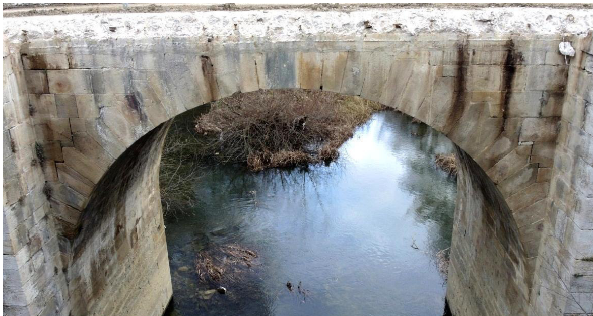
Figura 12.- Dovelas acodadas de las boquillas de las bóvedas de la arquería principal
