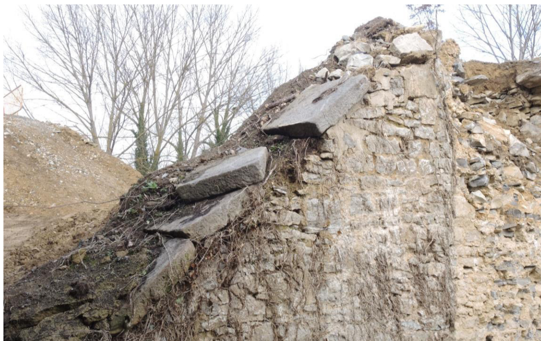
Figura 94.- Losas de remate de las aletas
