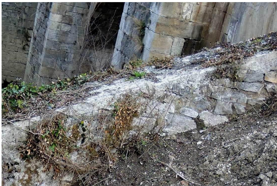
Figura 51.- Diferente remate de la coronación de la aleta aguas abajo del estribo izquierdo con hormigón en masa
