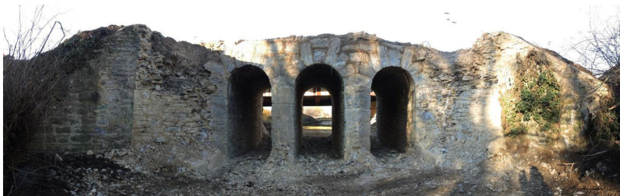
Figura 45.- Alzado aguas arriba de la primera alcantarilla de la margen derecha
