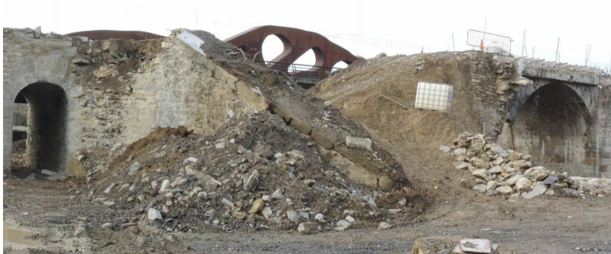
Figura 81.- Tramo del terraplén a excavar
