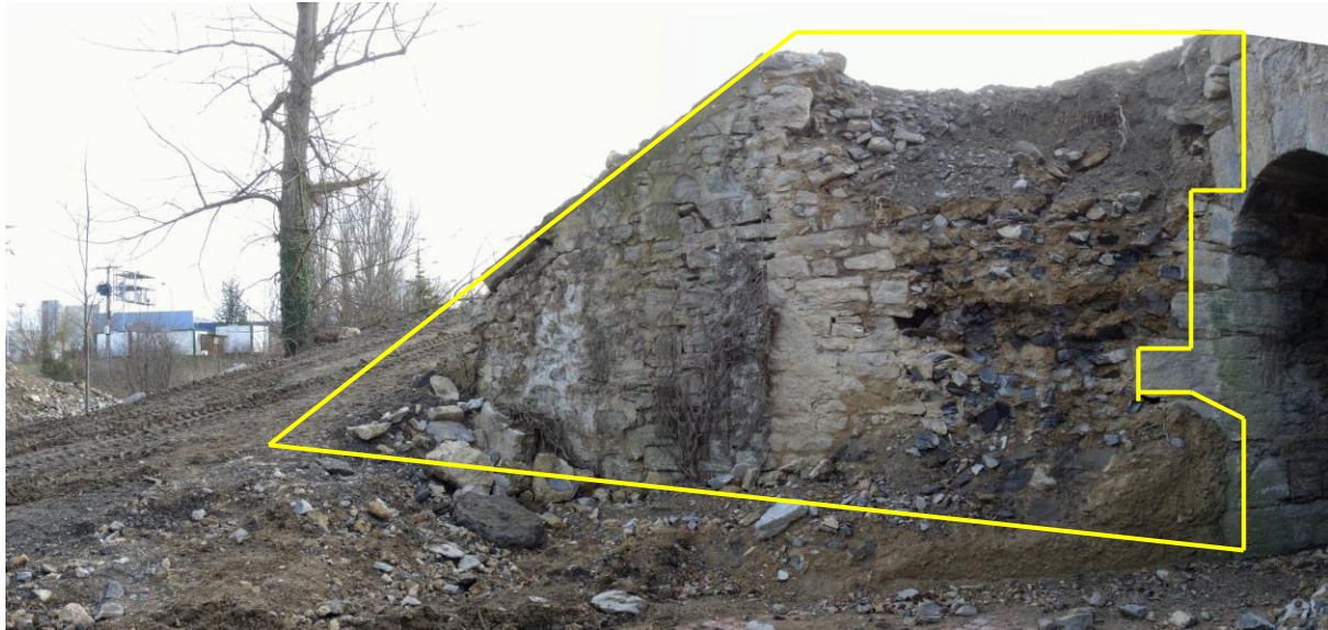
Figura 95.- Aletas de las alcantarillas a conservar
