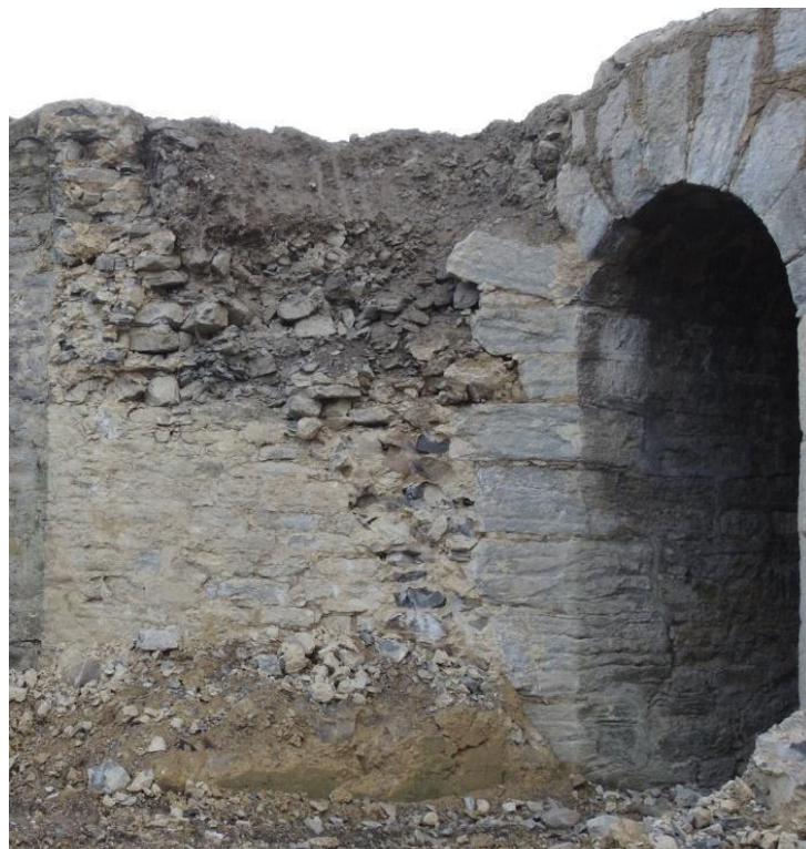
Figura 46.- Enlace de sillería de la aleta con la obra de fábrica
