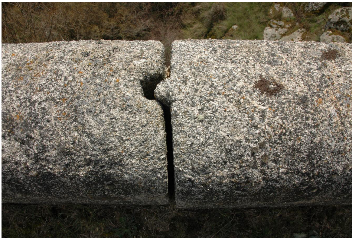
Figura 76.- Trabazón machihembrado entre las piedras del pretil
