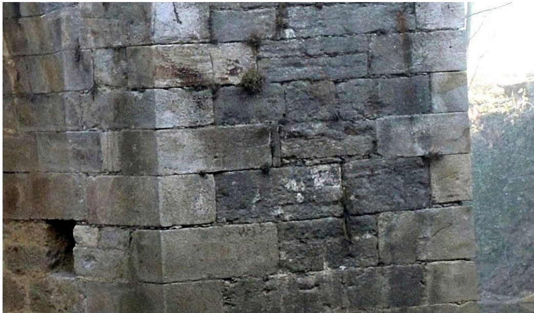
Figura 26.- Fábricas de los espolones de las pilas del Puente Viejo de Abetxuko
