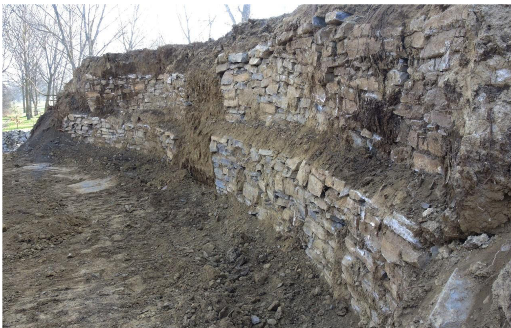
Figura 41.- Trasdós de las aletas de la alcantarilla de la margen izquierda
