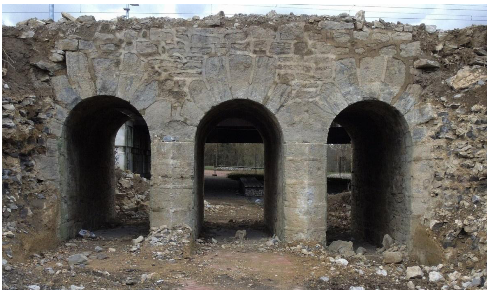
Figura 38.- Alzado aguas arriba de la alcantarilla vista de la margen izquierda
