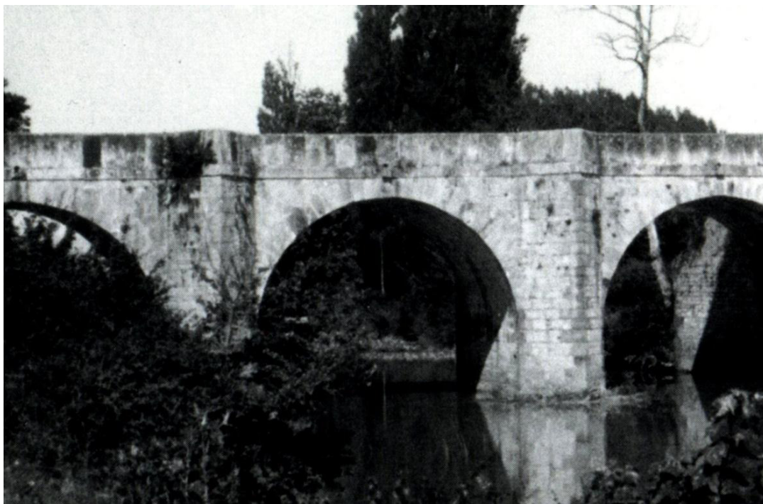
Figura 24.- Vista de los tajamares y sus apartaderos anteriores a la ampliación del puente
