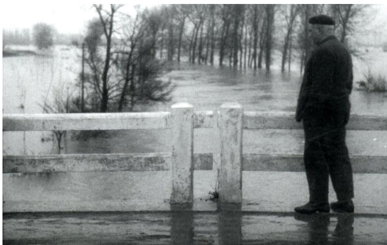
Figura 61.- Barandas de hormigón armado de la primera ampliación de la plataforma
