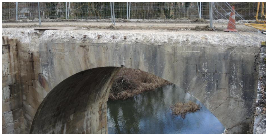
Figura 80.- Losa de hormigón en la plataforma
