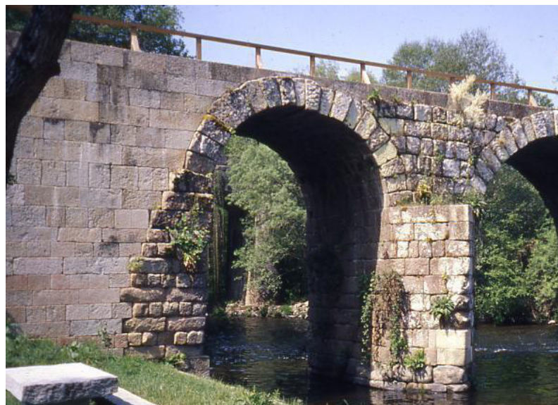
Figura 90.- Retranqueo de separación de las fábricas nueva y romana realizado en 1988 en el Puente Freixo (Ourense).
