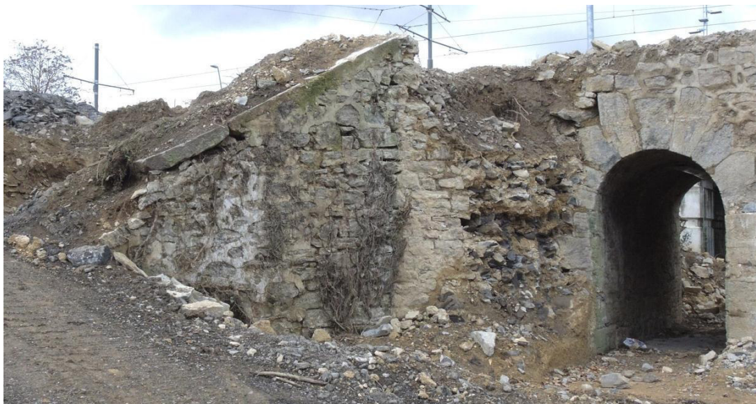
Figura 40.- Aleta izquierda de la alcantarilla de la margen izquierda
