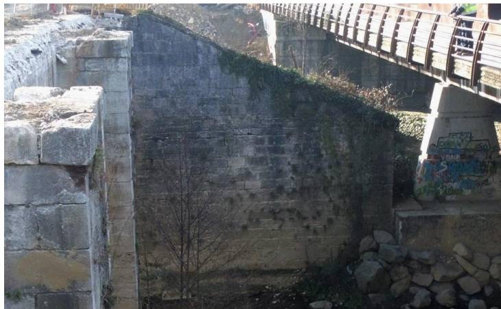
Figura 3.- Aleta aguas abajo del estribo izquierdo de la arquería principal
