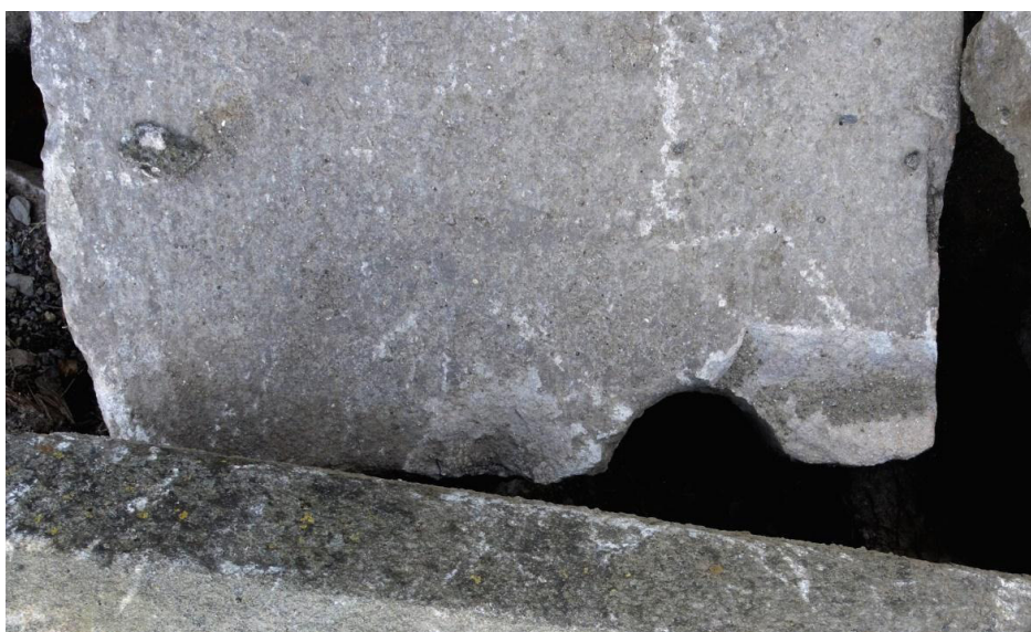
Figura 31.- Pieza del antiguo pretil con bocacaz circular
