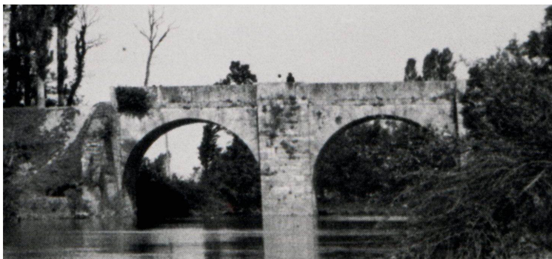
Figura 27.- Alzado aguas abajo antes de la ampliación de la plataforma
