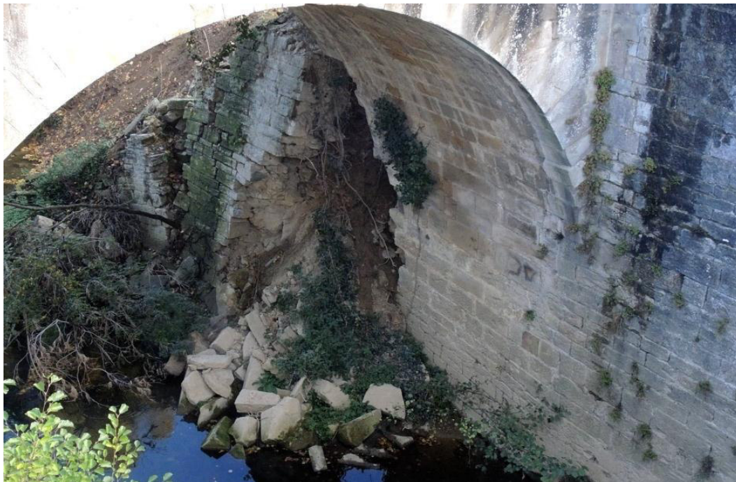
Figura 52.- Derrumbe de la aleta aguas arriba del estribo izquierdo
