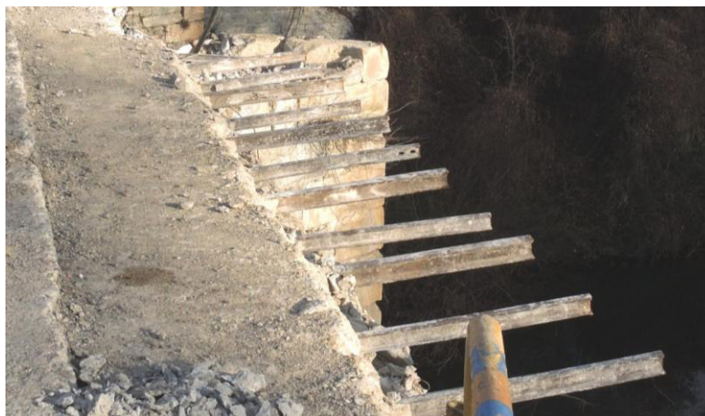
Figura 60.- Armado de los voladizos de ampliación con raíles de tranvía
