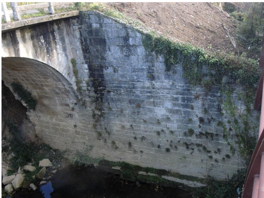
Figura 34.- Aleta aguas abajo del estribo izquierdo
