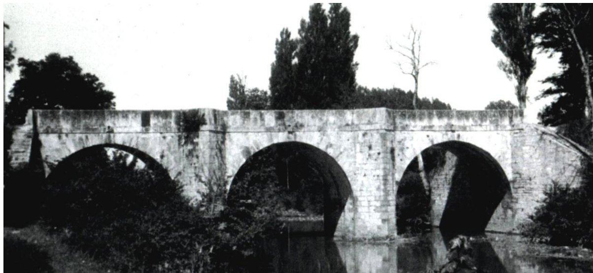
Figura 13.- Vista aguas arriba con la antigua cornisa bajo los pretilos
