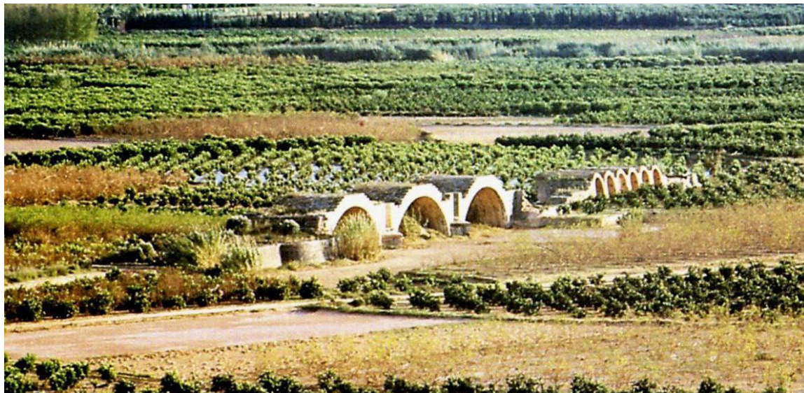
Figura 68.- Obra inacabada del Puente del Rey en el Camino Real de Madrid a Valencia, con una arquería principal y una alcantarilla de seis arquillos en uno de sus lados
