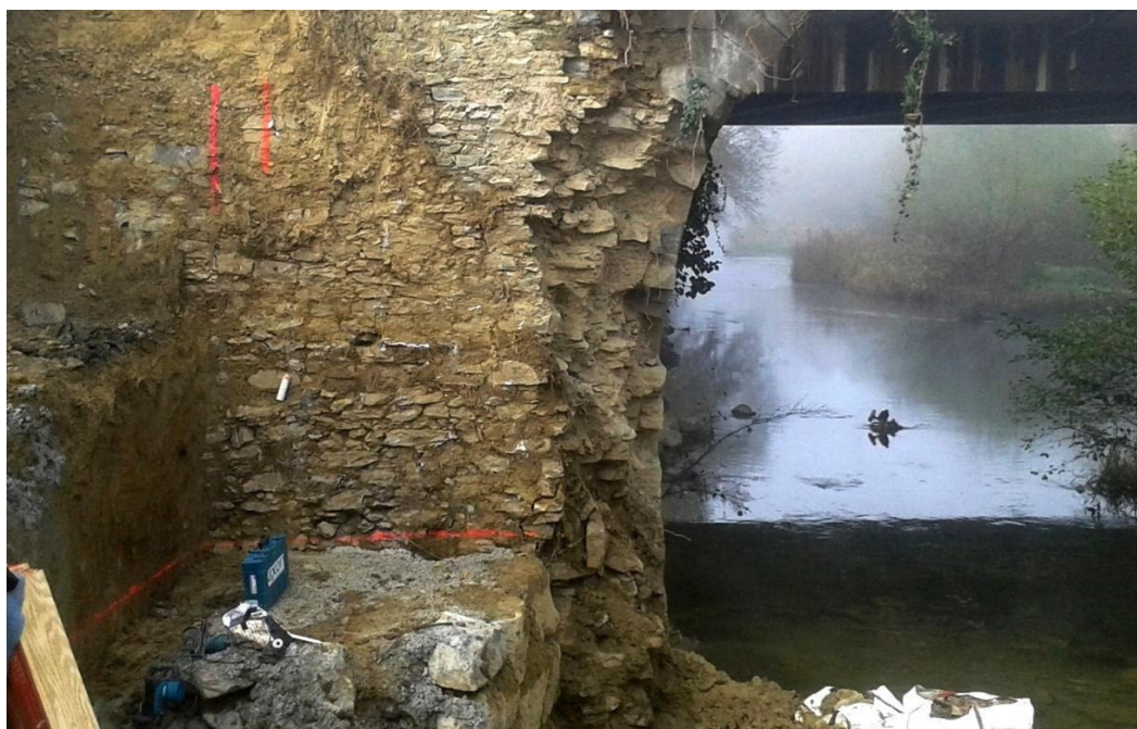
Figura 53.- Ruina parcial de la boquilla aguas arriba del arco izquierdo y de la esquina del estribo
