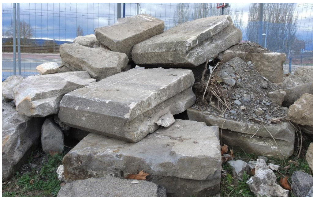
Figura 29.- Acopio de piezas del antiguo pretil
