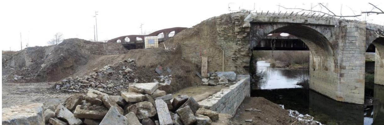
Figura 77.- Vista aguas arriba del estribo izquierdo
