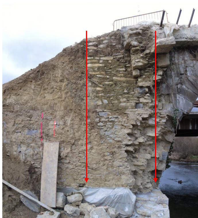
Figura 78.- Cuerpo principal del estribo izquierdo
