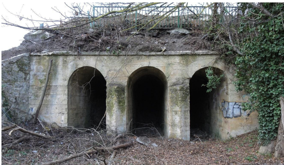
Figura 47.- Alzado aguas arriba de la segunda alcantarilla de la margen derecha
