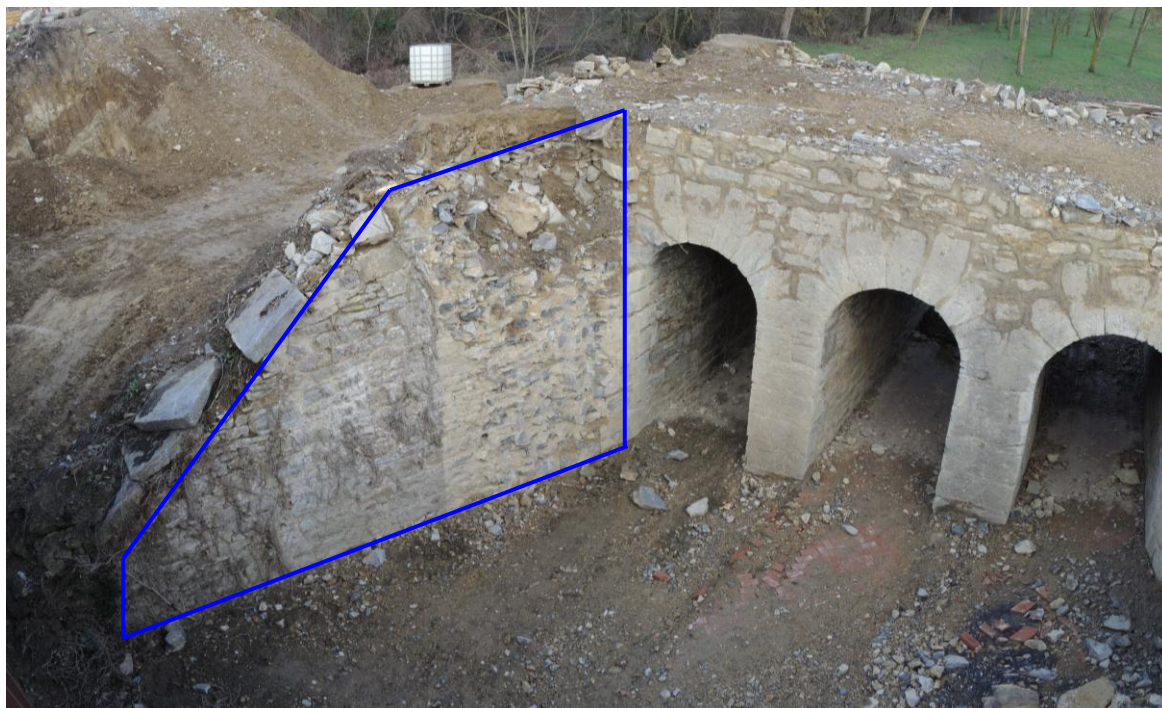
Figura 93.- Desmontaje de las aletas de las alcantarillas
