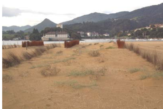
Foto nº 2.2: reposición captadores dunas D y U
