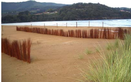
Foto nº 2.1: colocación captadores duna N
