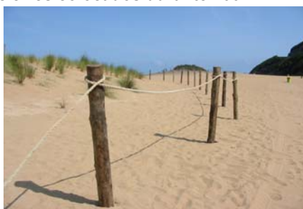
Foto nº 2.3: Características del cierre nuevo, estaca rústica y sogas de esparto
