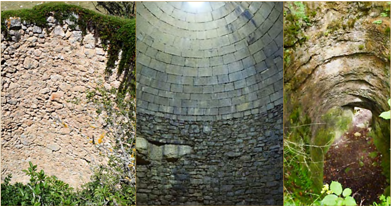
▲ Figura 20. En la parte superior izquierda, nevera del Toloño, consolidada con forro de mampostería; en la en la imagen central nevera de Yécora, con alzado en mampostería (todavía se aprecian restos de roca natural) y cúpula .de sillaría; a la derecha, posible pozo de nieve de Tobillas (Valdegovía), ejemplar únicamente excavado en la roca.
