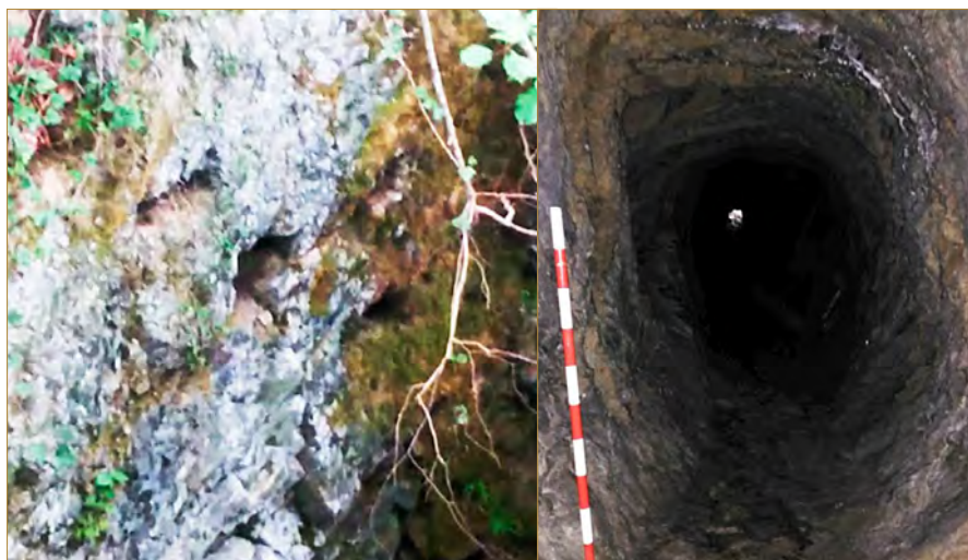
◀ Figura 28. Izquierda, mechinales escalonados tallados en la roca en Elurretxe para habilitar una estructura de madera o lajas salientes de apoyo; Derecha: Pasillo de acceso excavado en el substrato en Gabirizar formando un túnel de hasta 40 metros. Dado el contexto tradicionalmente minero de este entorno (zona del domo de Mutiloa), no se descarta que se aprovechara una antigua galería.
