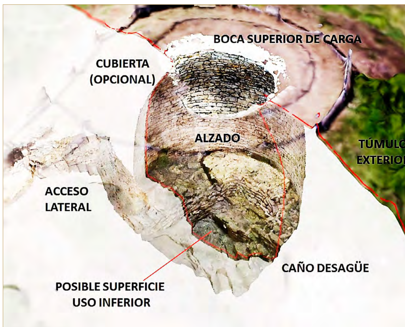
▲ Figura 19. Modelo tridimensional de la nevera de Labraza que utilizamos como base para señalar las principales partes constiyentes del pozo, de las que trataremos a lo largo de este apartado.
