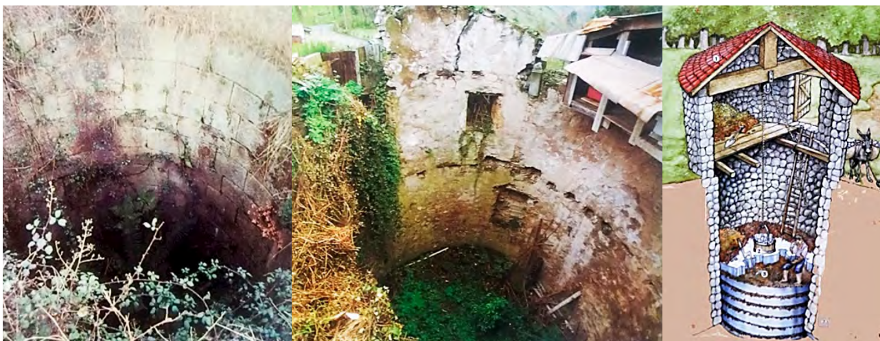
▲ Figura 23. A la izquierda, aparejo de sillería no habitual en los alzados de la nevera de Beltxikieta (Bizkaia); en el centro, nevera de San Roke en Bilbao. Sobre la boca del pozo, todavía se observa parte del alzado de la estructura que lo cubría y desde la que se extraía la nieve. Fuente: Manterola y Arregi (1994); a la derecha, reconstrucción hipotética de una nevera tipo de Bizkaia. Panel en la Nevera de Urkiola.
