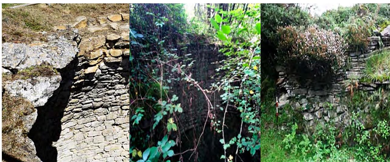
▲ Figura 25. De izquierda a derecha, cierre progresivo por acercamiento de hiladas en Labraza, en Irun y en Urnieta.
