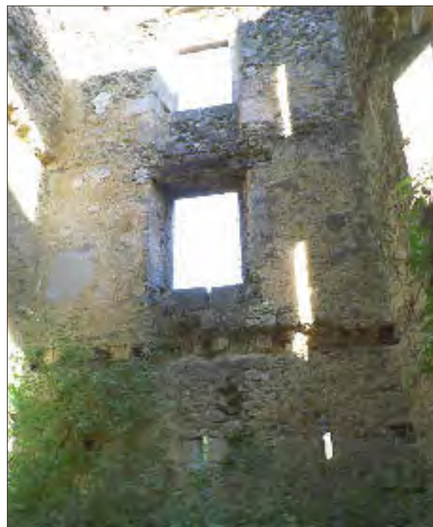
Dorrearen barrunbea. Solairuak gaitzeko horma-zuloak eta erretenak bereiz daitezke.
