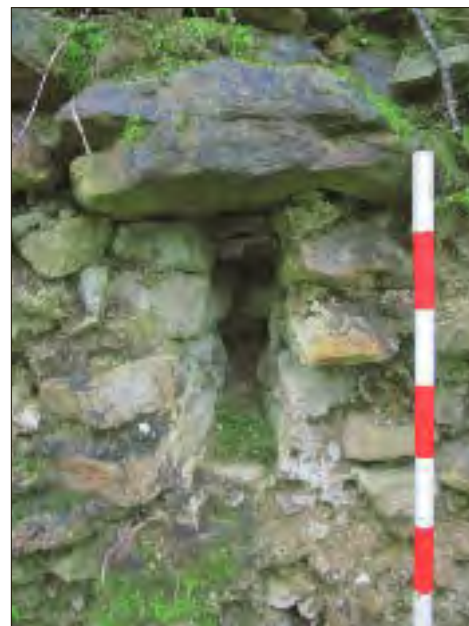
Behe oineko saietaretako baten xehetasunak. Detalle de una de las saieteras de la planta baja.
